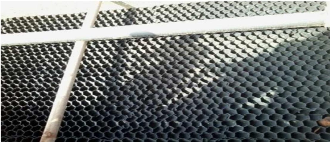
**Figure 16 :** Décanteur lamellaire.
