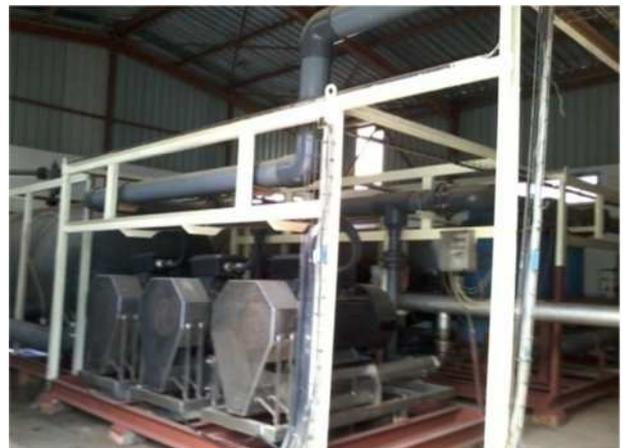
**Figure 18 :** Filtre à charbon et filtre à sable.
