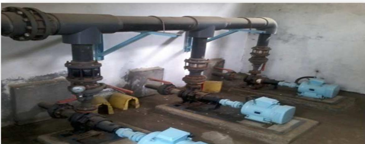
**Figure 17:** Pompes de refoulement.
