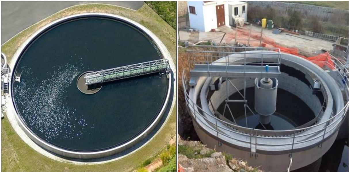
**Figure 21** : Dessableur de forme circulaire avec une arrivée d'eau périphérique et un déversoir central.
