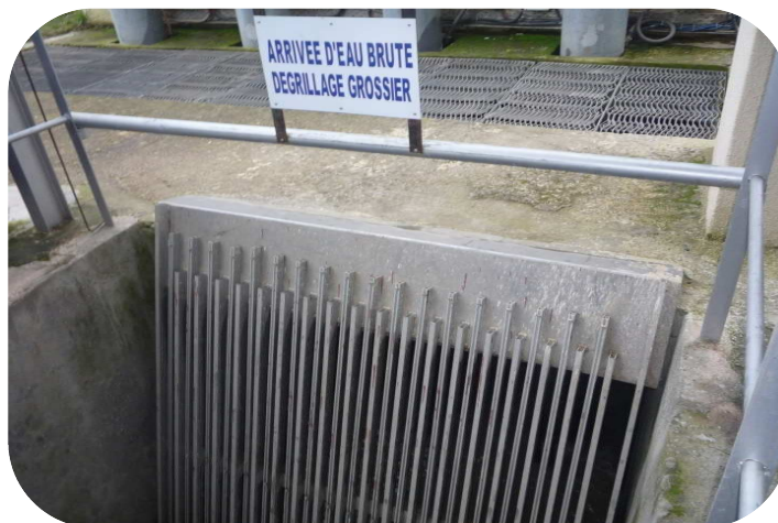
Figure 10 : dégrilleur grossier
