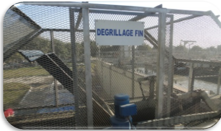
Figure 11:degrilleur fin
