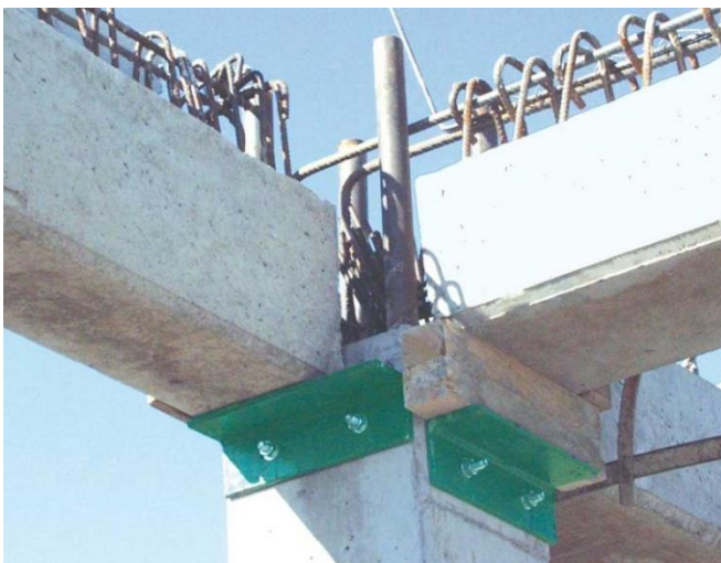
Figure 60: Assemblage poteau poutre. Source: https://www.seac-gf.fr/igmedias/Poutre/33/appuis-mini-d.jpg .
