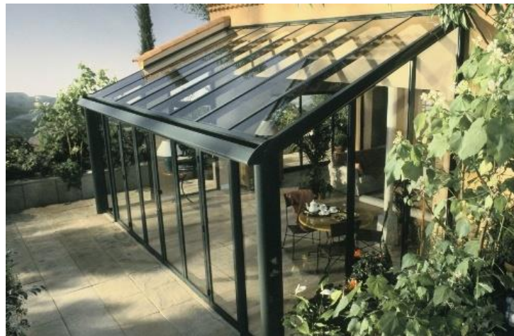
Figure 48 : Une serre bioclimatique. Source : https://www.lepanneausolaire.net/images/23-Serre-solaire-ou-veranda.jpg .
