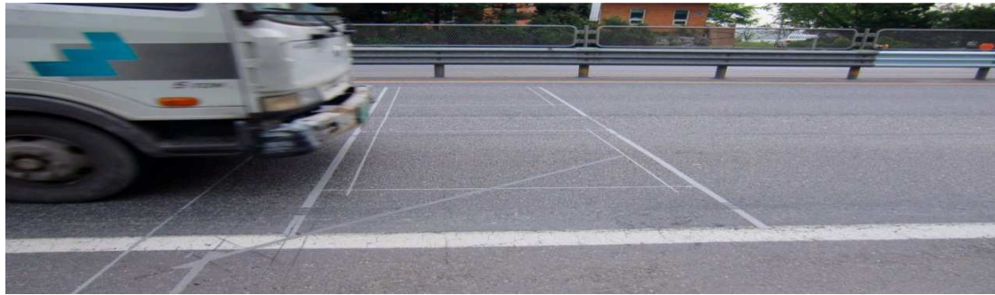
Figure 3: Boucles électromagnétiques pour le comptage permanent (monde de génie civil)
