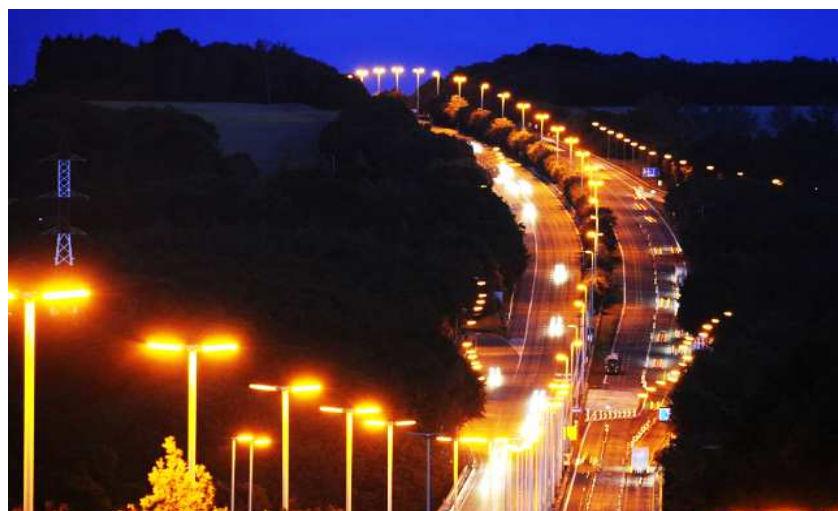
Figure 27 : éclairage des autoroutes
