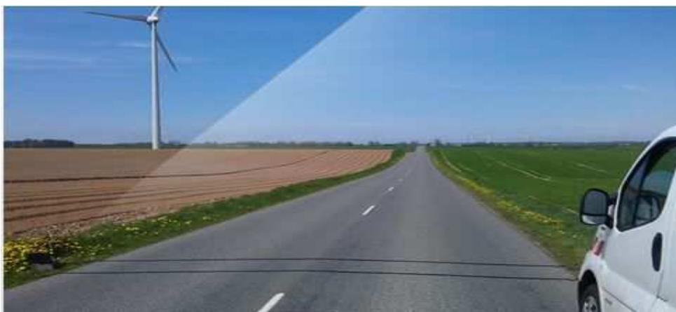
Figure 4: Le comptage temporaire à l'aide d'un tube pneumatique (éclats-antivols)
