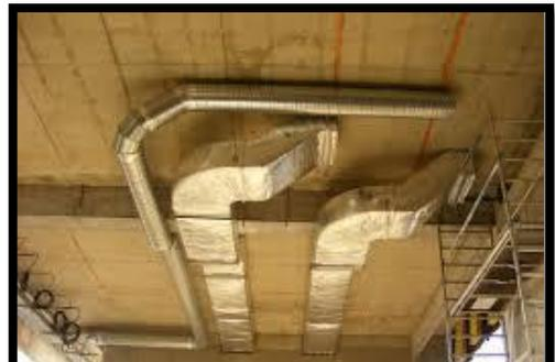
Figure 195: photo des gaines de climatisation
