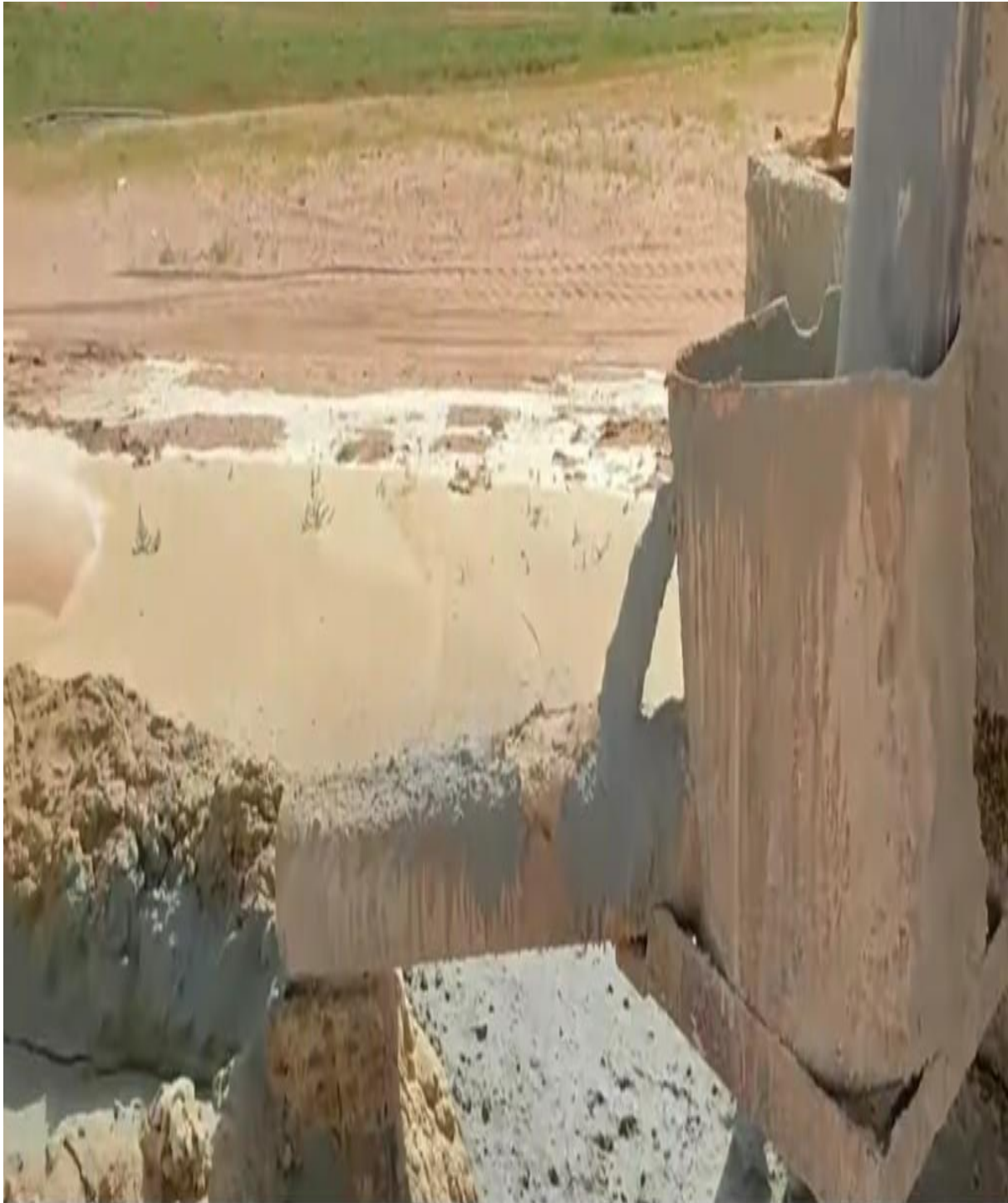
Figure 4.8 : Vidange de la curette de ses déblais
