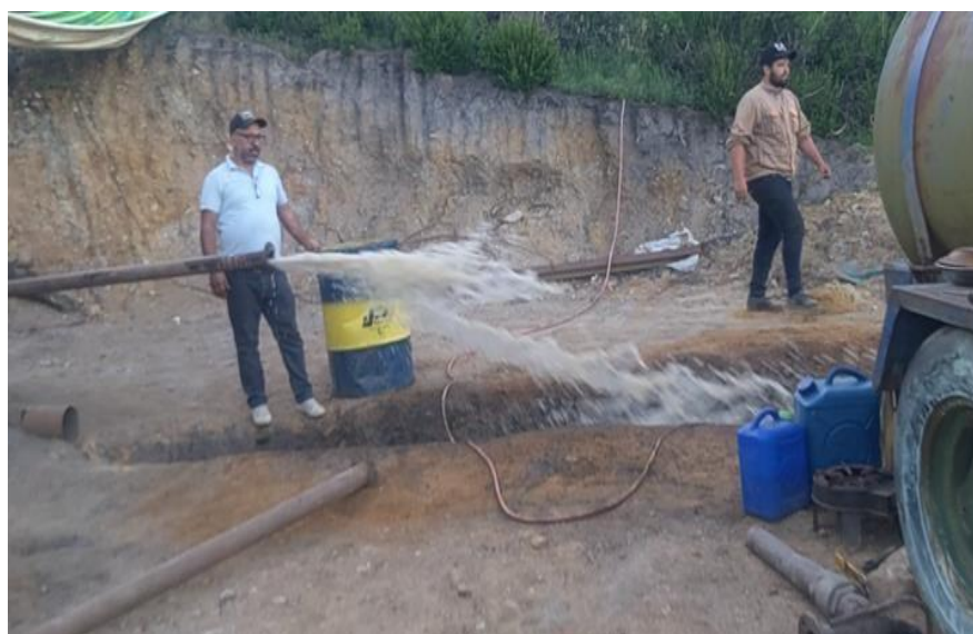
Figure 4.17: sortie d'eau à haute pression avec des déblais.
