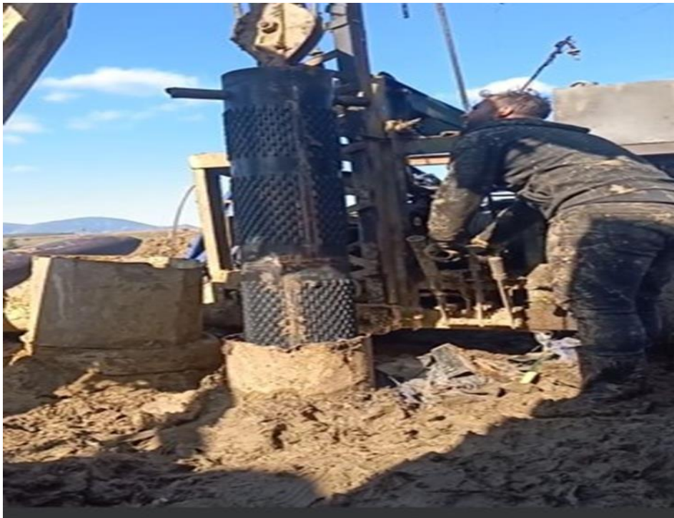
Figure 4. 14: la mise en place du tubage.
