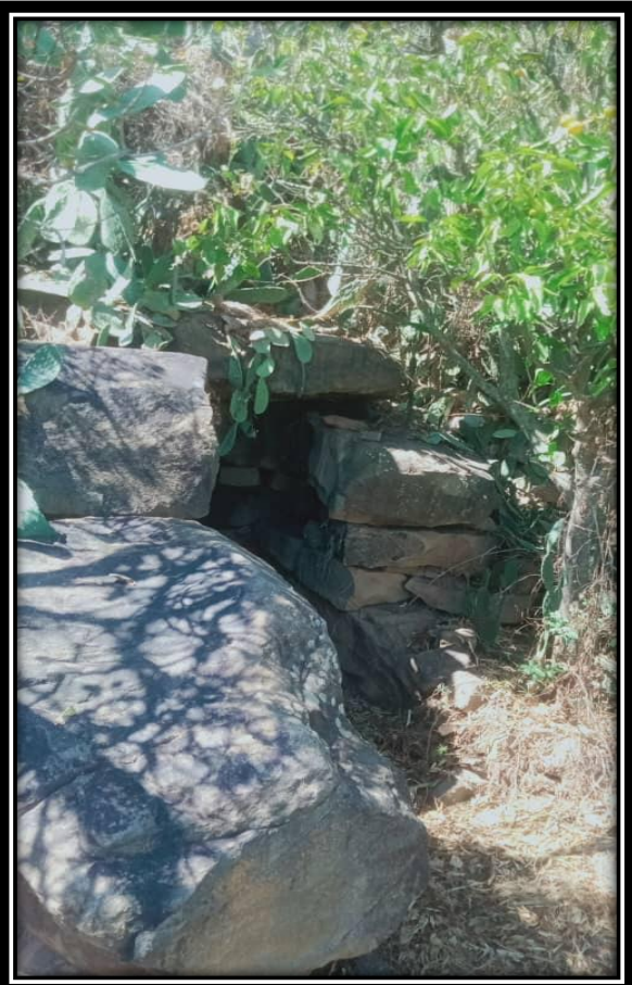
Vue de l'exterieur
