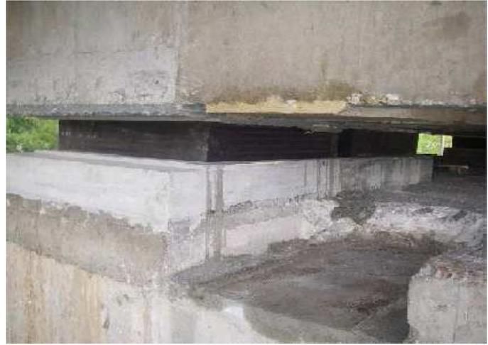
**Fig. X.1 : Appareil d'appui en élastomère fretté.**
