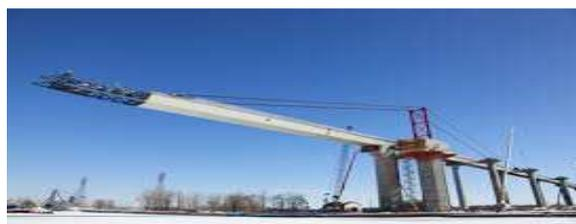
**Fig. II.5. Construction par poussage**
