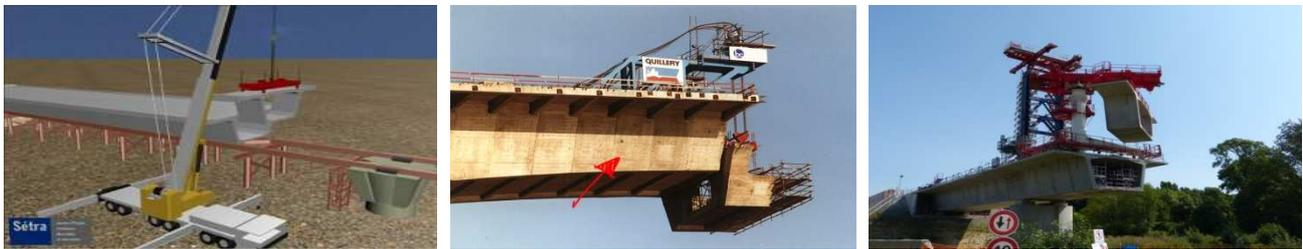
**Fig. II.10 : Pose des voussoirs préfabriqués**
