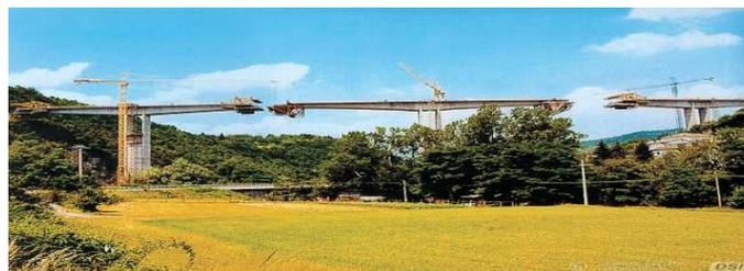
**Fig. II.7. Construction par encorbellement**
