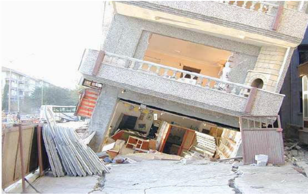
Figure I.8: Effet de liquéfaction des sols [2].
