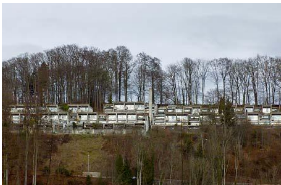
Figure n°125 : Ensemble d'habitation de Halen Kirchlindach, Suisse Source : www.google image.com
