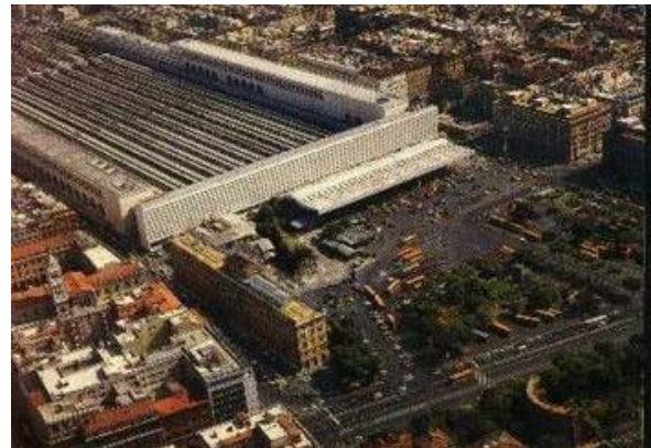
Figure n°58 : LA GARE DE TERMINI Source : Moniteur des hôtels
