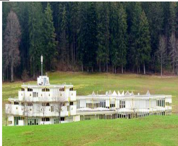
Figure n°132 : Centre interrégional de perfectionnement (CIP), Tramelan Source : www.google image.com
