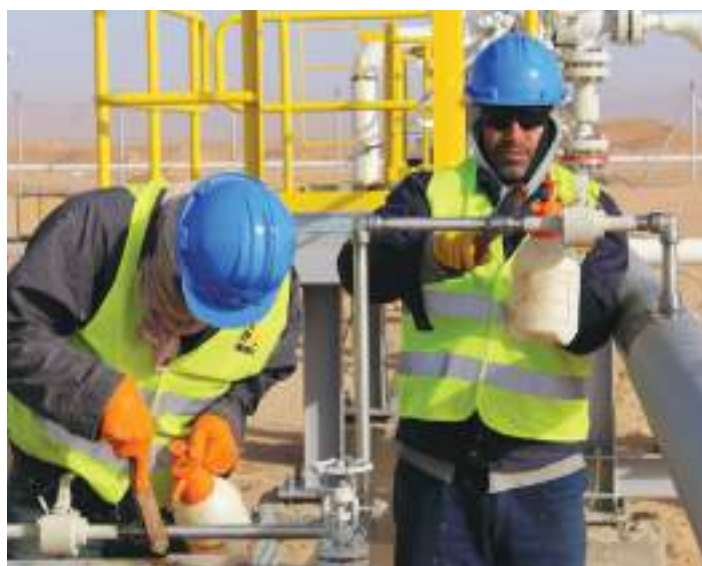
Projet raccordement de 36 puits Ohanet
