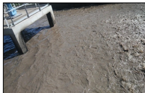
Figure 10 : Bassin de dénitrification.
