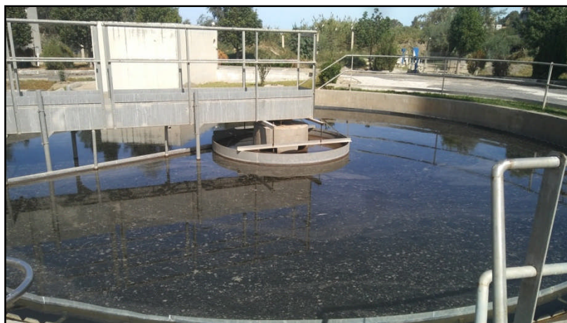
Figure 12 : Clarificateur.
