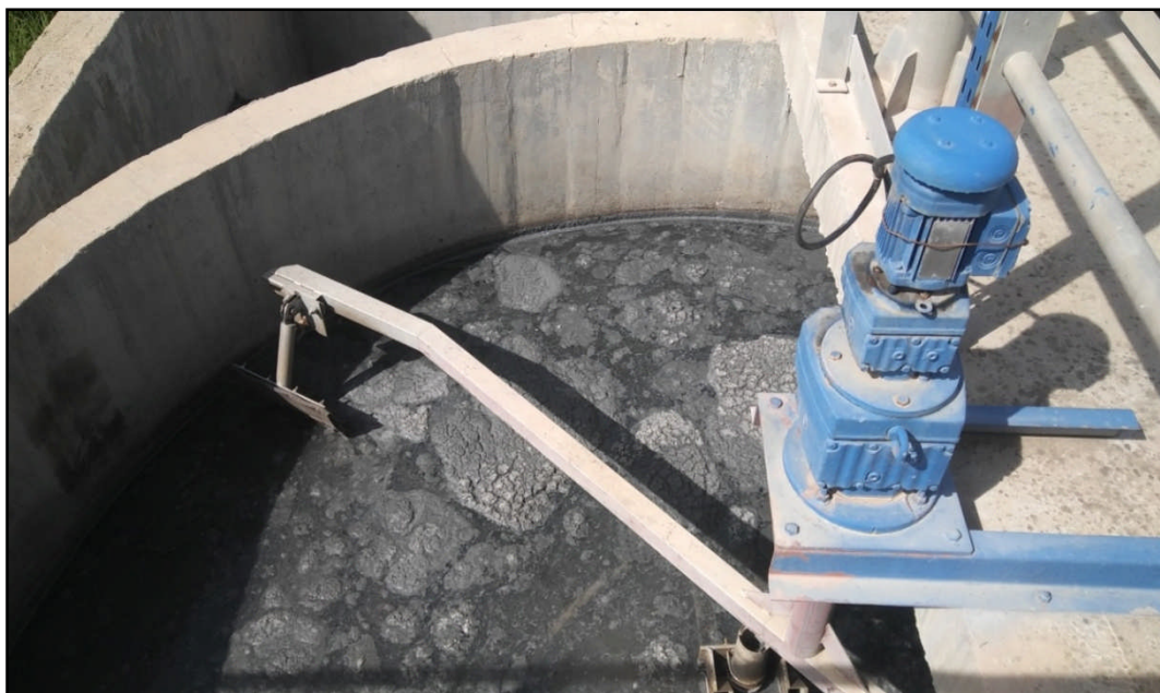
Figure 07 : Bassin déshuilage-dessablage.
