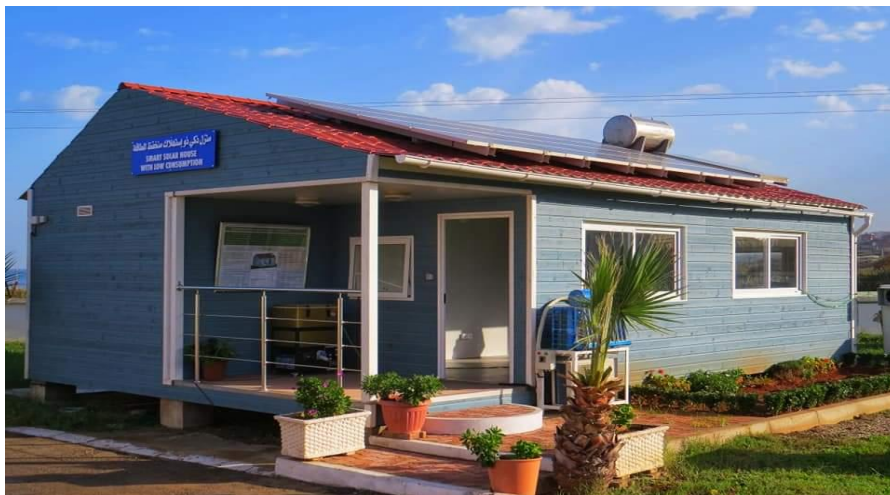
Figure IV.15. Vue d'ensemble de la maison solaire basse consommation installée à l'UDES
