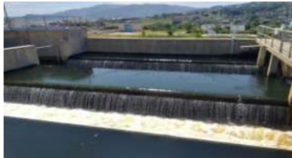
Figure 7. Chambre de dissipation
