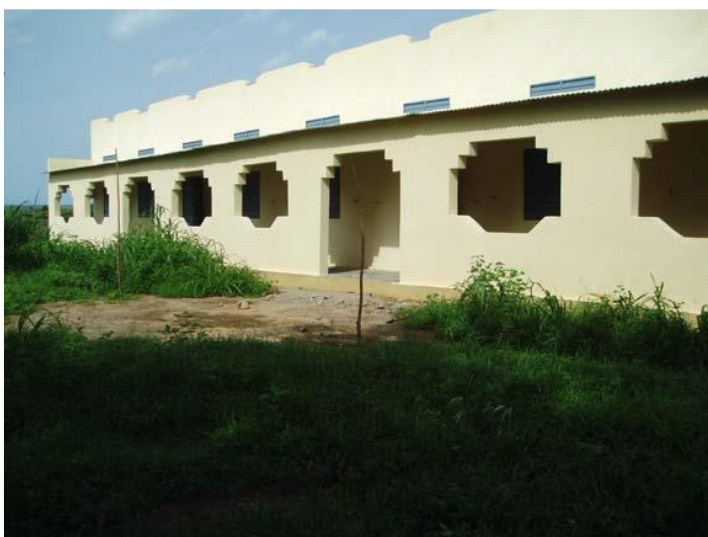
Photo N°2 : Ecole fondamentale de Kouroukoula, réalisé en 2005
