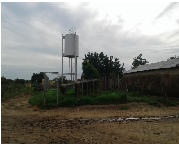
Photo N°11 :Château d'eau de Tafacirga
