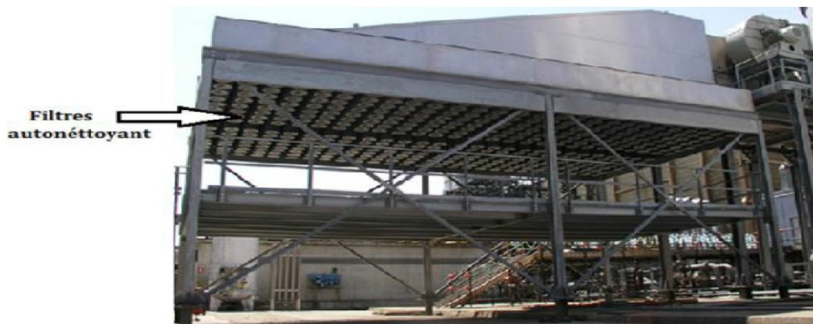
Figure II.3 : Filtre autonettoyant
