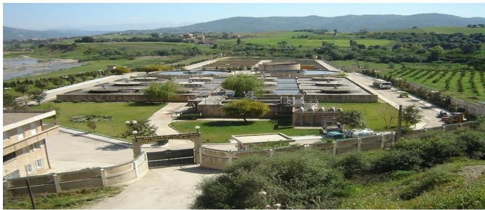
Figure 8. Image de la Step Est de pont de bougie (ONA, 2022).
