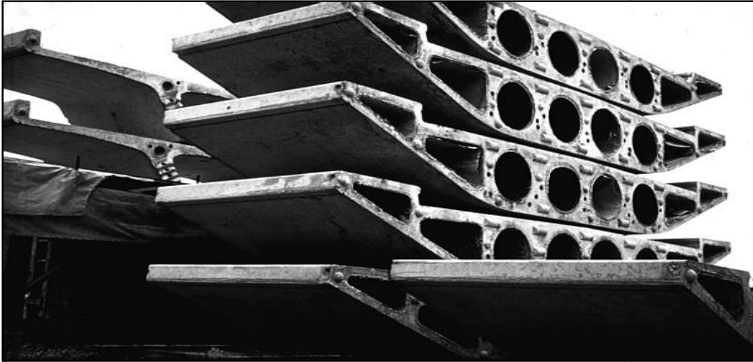
Figure 1.16 : stockage des voussoirs
