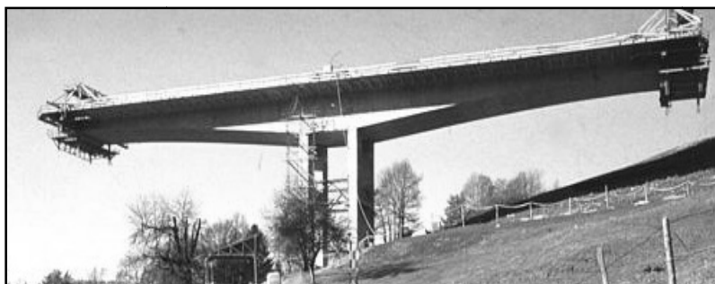
Figure 1.15 : Stabilité du fléau lors de la réalisation
