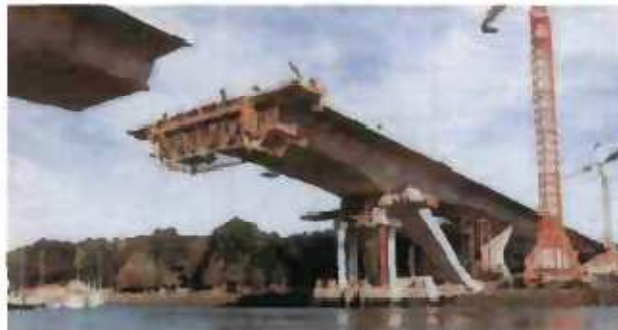
Figure 1.6 : Construction à béquilles d'Auray (Setra ,2003).
