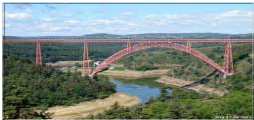
Figure 5 : Le Viaduc de Garabit (1880 – 1884)
