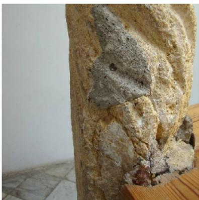
**Photo 3.9** Détérioration de la colonne en tuf/petite tache de coloration blanchâtre
