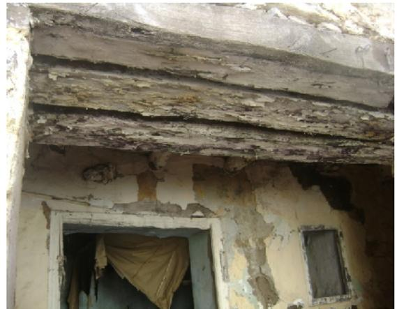
**Photo 2.48** : Franchissement des ouvertures sous forme de plates bandes.
