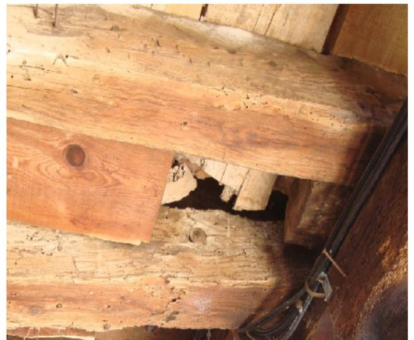
**Photo 3.13 :** Rupture de la poutre par cisaillement et flexion
