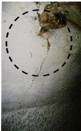
**Photo 3.29:** Fissure sous solive sous plancher / tassement
