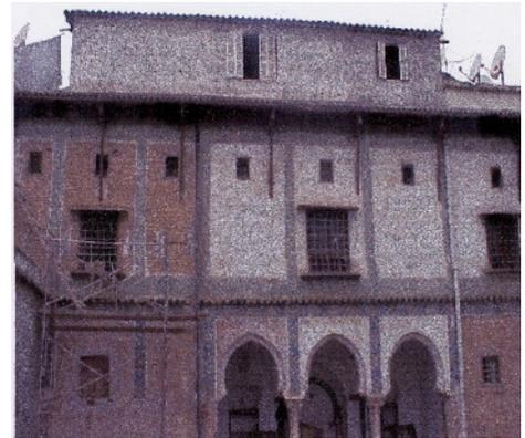
**Photo 3.2:** Sur -élévation illicite
