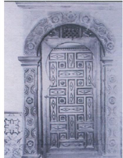
**Photo 2.36:** chambranle en marbre, sans claveau au niveau de la clef
