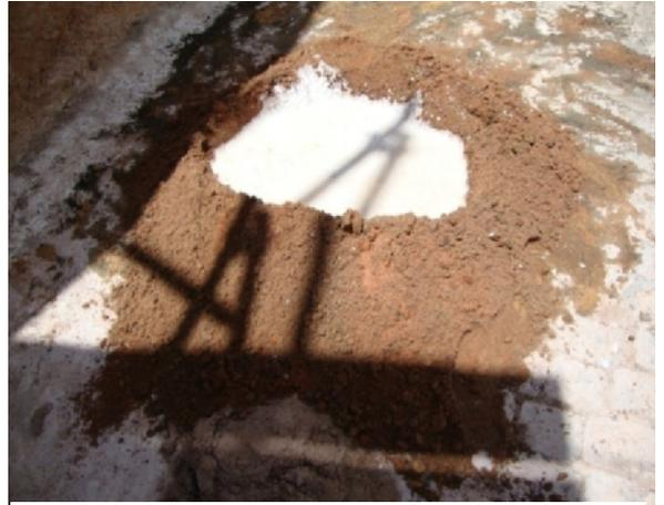
**Photo 2.31:** Enduit sur murs en maçonnerie (sable, chaux, eau de gâchage).
