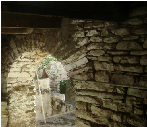
**Photo 2.47** : Franchissement des ouvertures sous forme d'arcature.
