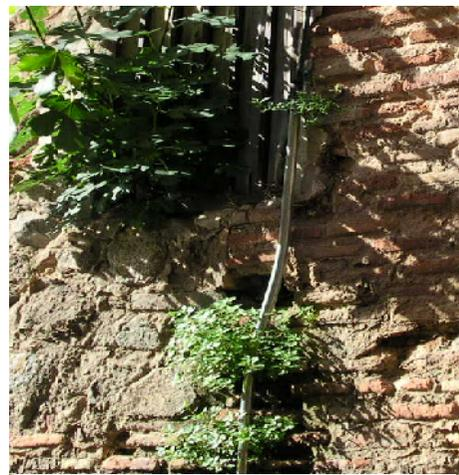
**Photo 3.21:** Présence de plantes (le figuier) dans un mur
