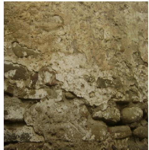
**Photo 3.4:** Détérioration de l'enduit par vieillissement
