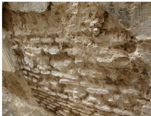
**Figure 2.4 et Photo 2.6 :** Mur mixte, à proportion égale de brique en terre cuite et de pierres (moellons).
