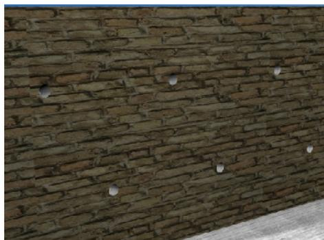
**Figure 4.1:** trous forés afin d'injecter des produits imperméabilisants.
