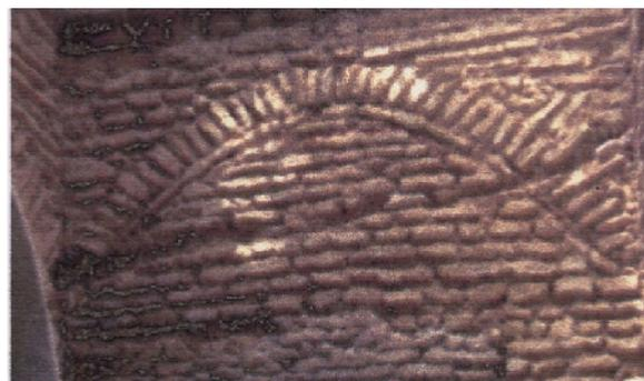
**Photo 2.4:** Mur plein en briques en terre cuite renforcé par un arc de décharge.
