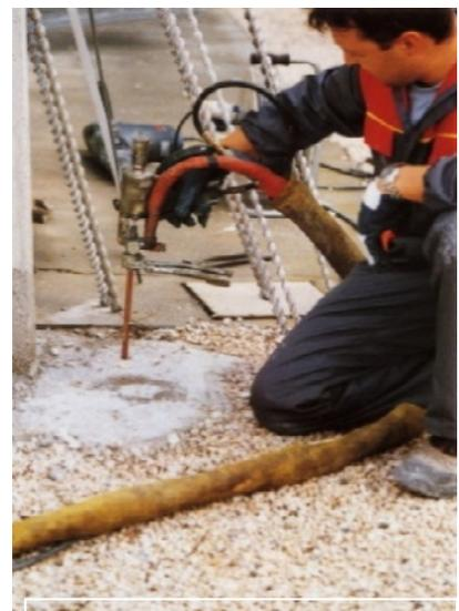
**Photo 4.1:** Consolidation par injections superficielles
