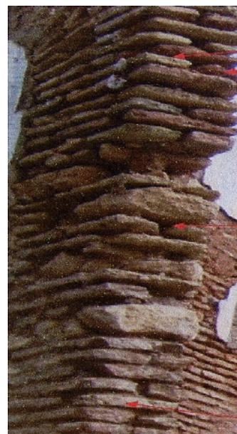
**Photo 2.5:** Mur en brique de terre cuite renforcé par un arc de décharge.
