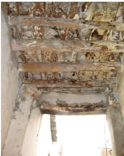
**Photo 3.23:** Fluage du linteau induisant des fissures de part et d'autre.
