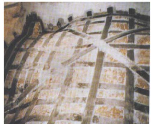
**Figure 4.42:** Renforcement de voûte par des polymères à fibres renforcée
