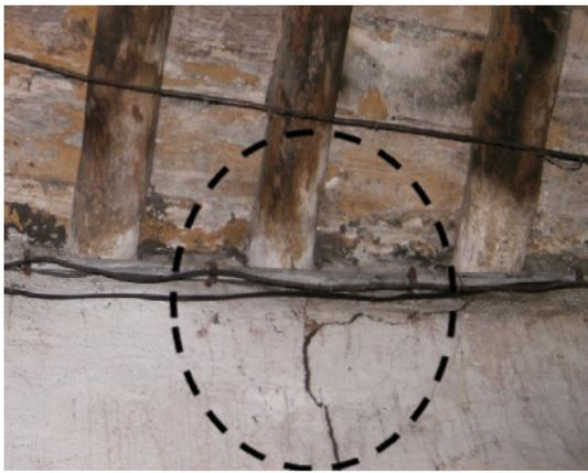
**Photo 3.25:** Fissure démarrant à la hauteur du plancher
