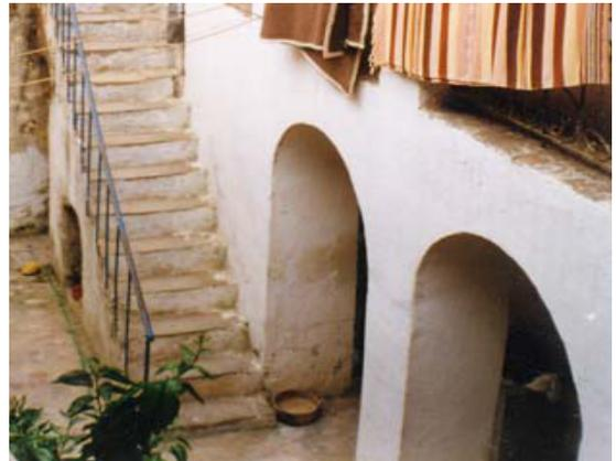
**Photo 2.18:** escalier conçu Parallèlement et au mur de façade à Dellys
