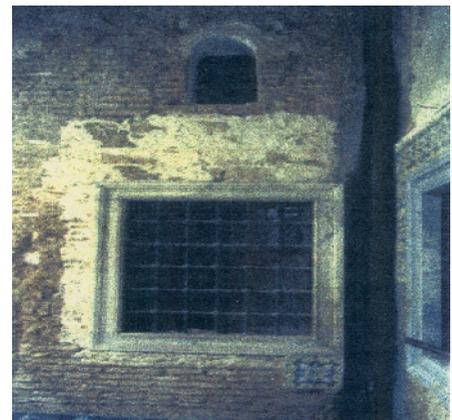
**Photo 3.18:** Efflorescence sur un mur.
