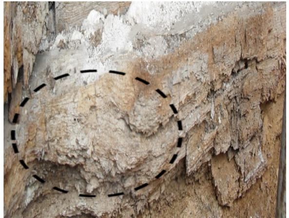
**Photo 3.12:** Pourriture blanche cause de dégradation et de perte de résistance du bois
