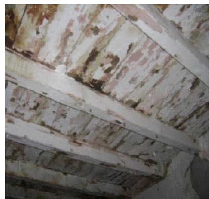
**Photo 2.21:** Plancher sur solives équarries et voligeages
