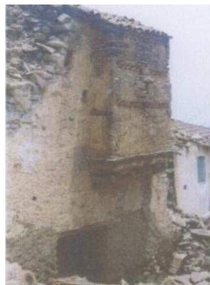
**Photo 2.38:** Encorbellement supportés par des rondins de thuya en bois horizontaux
