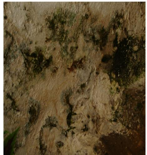
**Photo 3.19:** Prolifération de salissures vertes due à une humidité permanente
