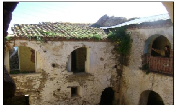
**Photo 2.28:** une charpente simple, portant de la tuile canal
