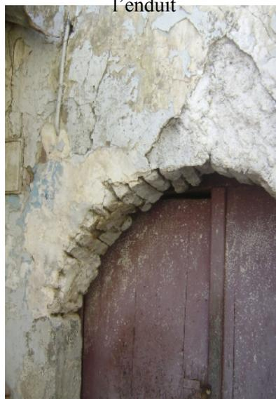
**Photo 3.6 :** Vieillesse de l'enduit, décollement et
