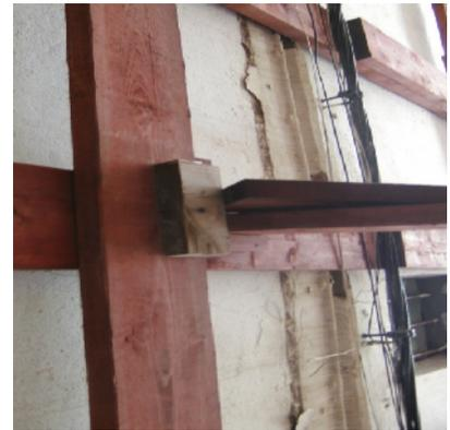
**Photo 3.26:** Fracture verticale dans l'angle du mur
