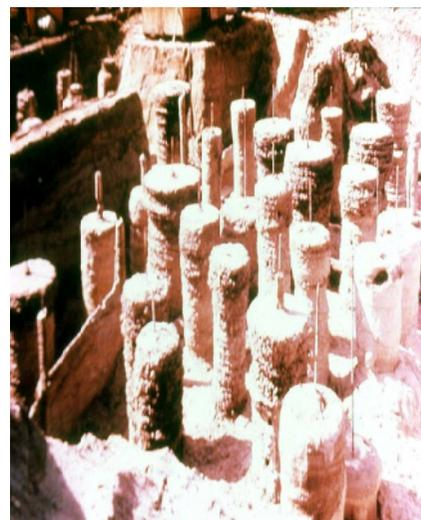
**Photo 4.3:** colonnes de fondations (béton/sol)
