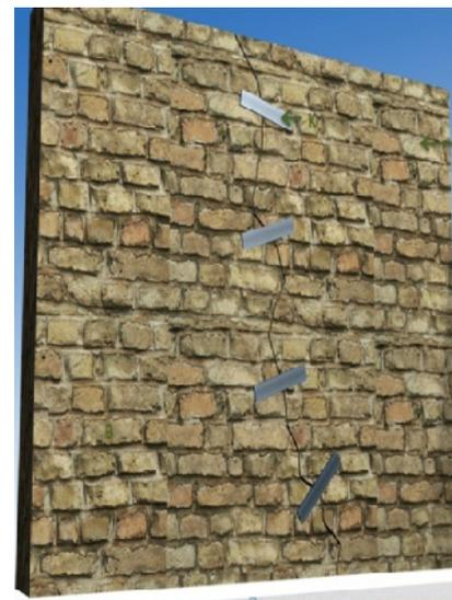
**Figure 4.31 :** Remplacement des parties lézardées par des agrafes métalliques
