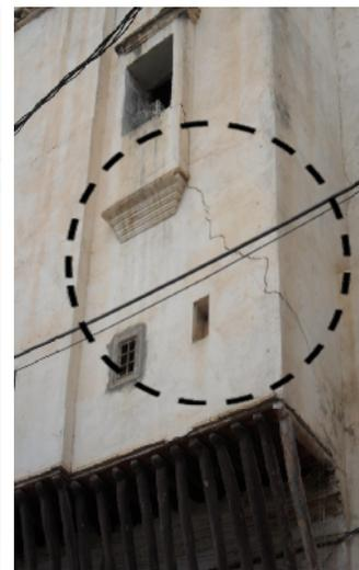
**Photo 3.30:** Apparition de fissures dans le mur d'allure oblique
