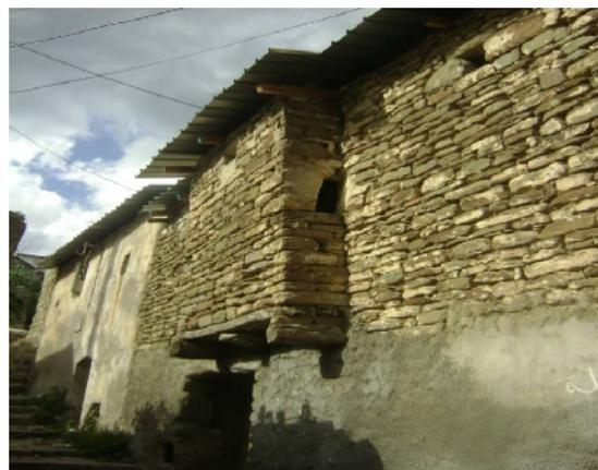
**Photo 2.9:** Mur hourdé en appareillage de pierre Casbah de Dellys.
