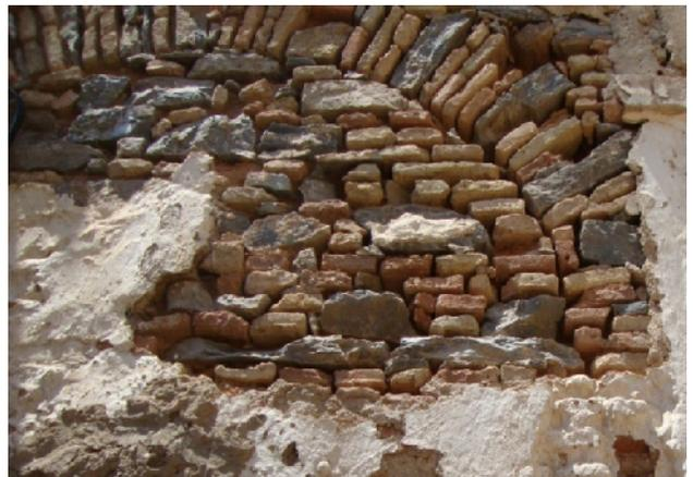
**Photo 2.8:** Mur mixte renforcé par un arc de décharge.
