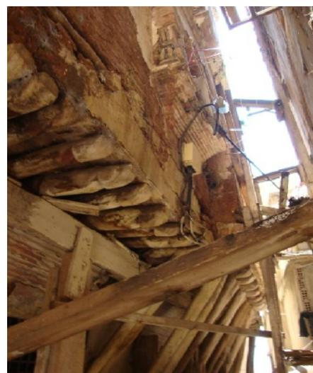
**Photo 3.33:** Bombement sur le mur de façade
