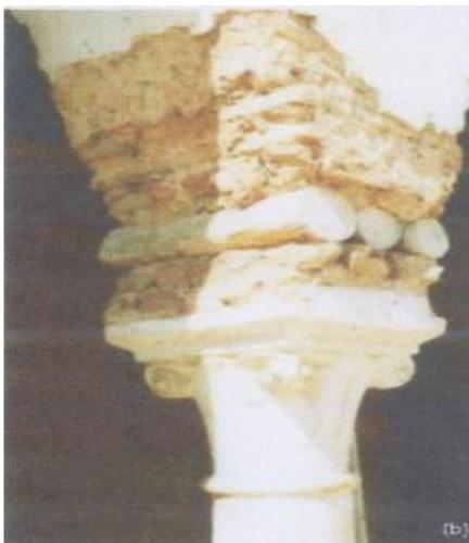
**Photo 2.13** : superposition une rangée de trois rondins de thuya à une assise de deux rangées de briques de terre cuite
