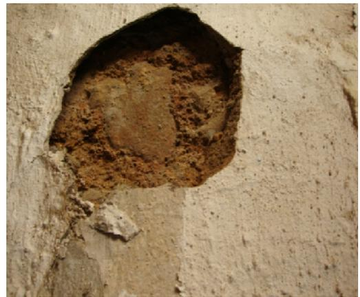
**Photo 2.33 :** Enduit à base de terre argilo-sableuse et chaux
