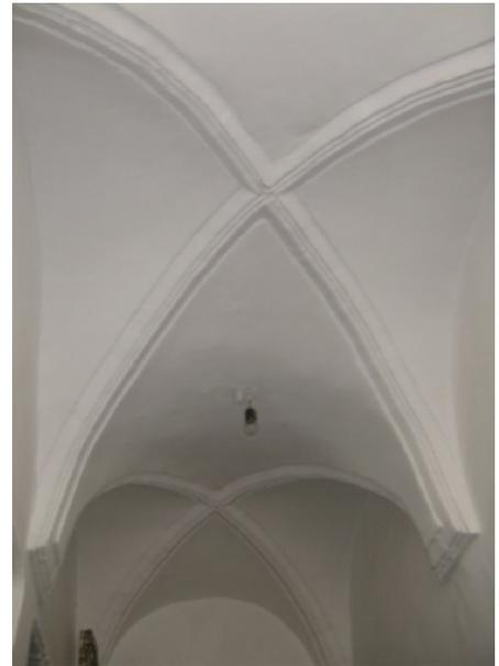
**Photo 2.24:** Voutes croisées en arête recouvrant un escalier dans une grande demeure
