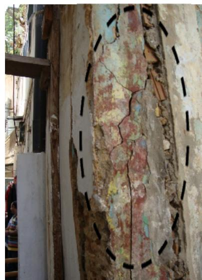
**Photo 3.31:** Fissure intérieure, parallèle à ses parements (désolidarisation).
