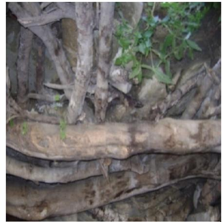
**Photo 2.22** flèche induite par le poids de la terre entraînant le fléchissement des solives
