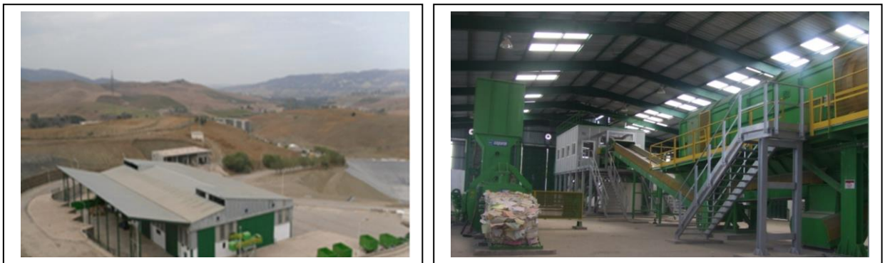
Figure N°04 : Le centre de tri de Oued-Falli vue extérieur et intérieur
