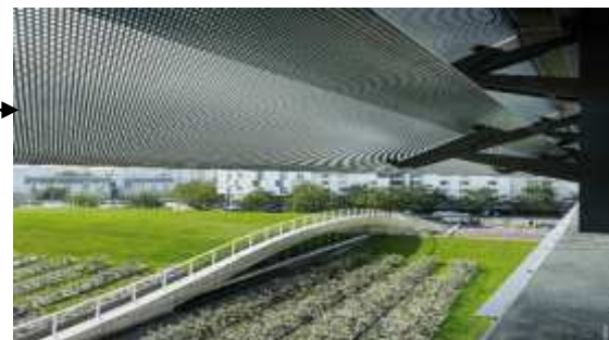
Figure II.68 : Des cellules photovoltaïques sur les brises soleil de la façade sud. Source : www.pinterest.fr/pin/372109987937056242/
