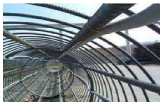
Figure IV.28 : fondation thermoactive intégré dans un pieux. Source : www.cd2e.com/sites/default/files/Cd2eS_tatic_contenu/mercrediinfo/presentation_geothermieprofessionnelle_oct10_mercinfocd2e.pdf .
