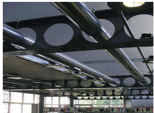
Figure III.42 : poutres alvéolaires Source : http://www.archiexpo.fr/prod/arcelormittal-long/product-55693-482786.html
