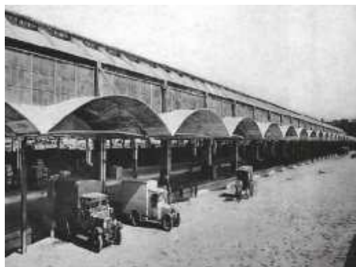
Figure II.37 : La Halle Freyssinet, en 1932 Source : Google image
