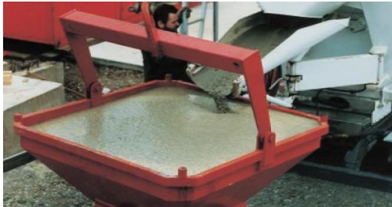
Figure 1.4 : Aspect d'un béton autoplaçant à l'état frais.
