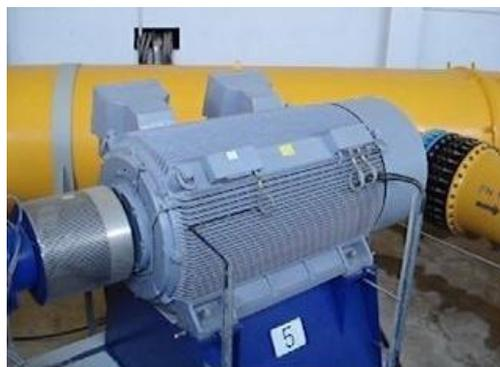
Figure I.13 : moteur asynchrone.
