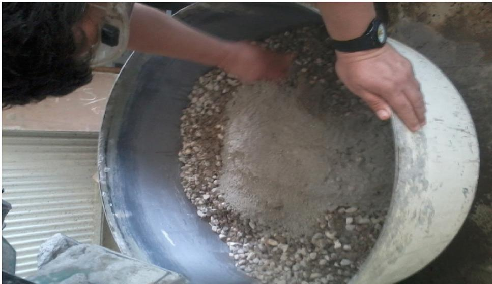
**Figure IV.6 : Ajout des autres granulats et du ciment au mélange précédent.**
