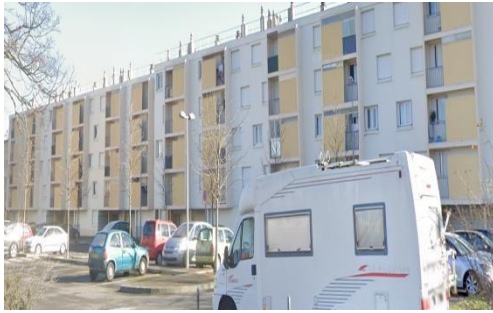
Figure 59:Le bâtiment c avant la réhabilitation
