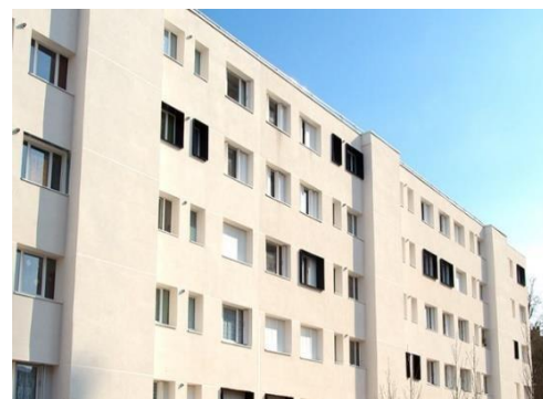
Figure 12 : Les façades urbaines avant la réhabilitation
