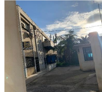
Figure 106 : Vue sur la poste CHIKHI
