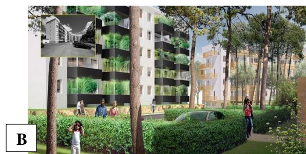
Figure 10 : Le bâtiment B après réhabilitation
