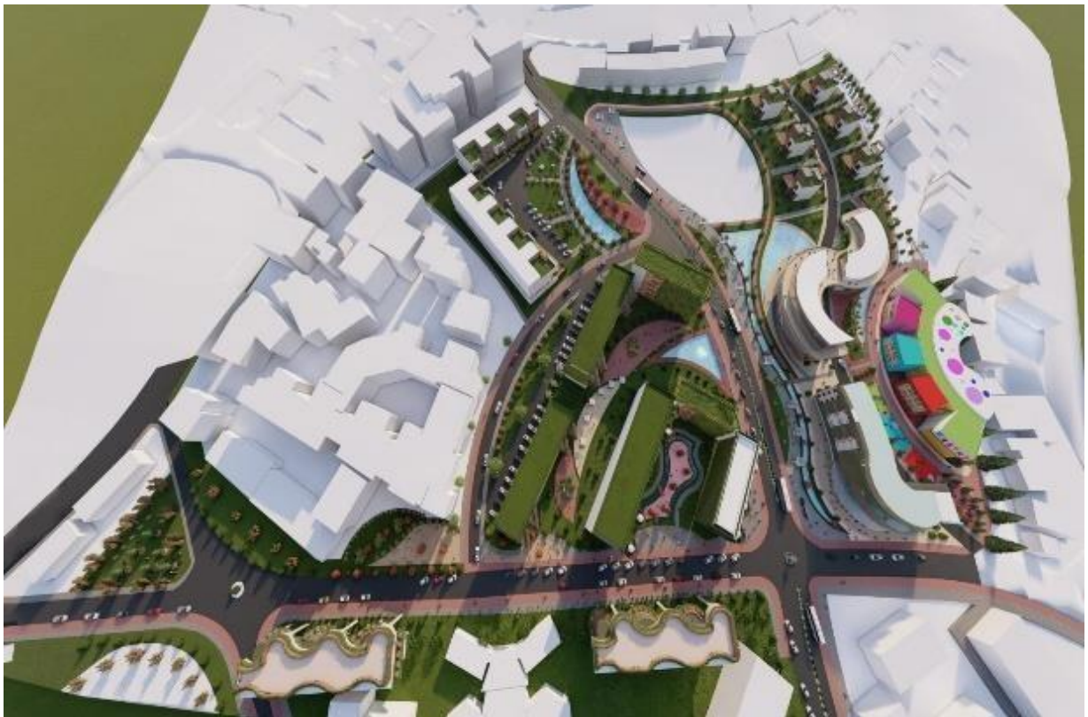
Figure 124 :Vue sur le quartier après intervention urbaine
