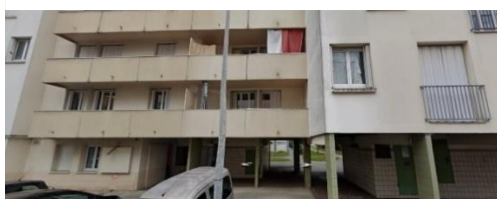
Figure 57: Le bâtiment B avant la réhabilitation
