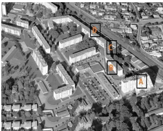
Figure 13 : Le quartier avant la réhabilitation
