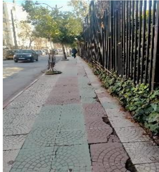
Figure 60 :Vue sur la rue BOULILA séquence N01
