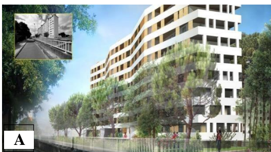
Figure 11 : Le bâtiment A après réhabilitation
