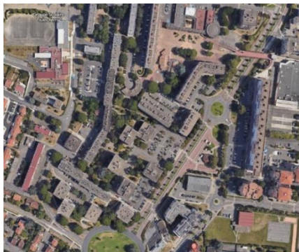
Figure 48:Vue aérienne sur l'espace de liaison avant sa création
