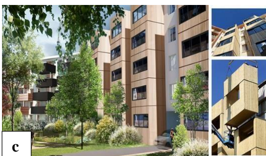
Figure 9 : Le bâtiment c après réhabilitation
