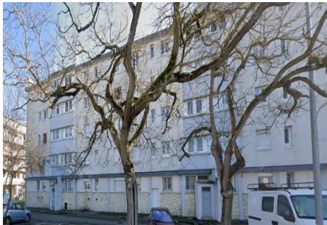
Figure 61:Le bâtiment D avant la réhabilitation
