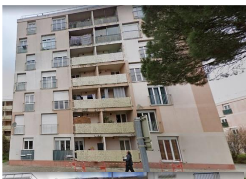
Figure 55: Le bâtiment A avant réhabilitation
