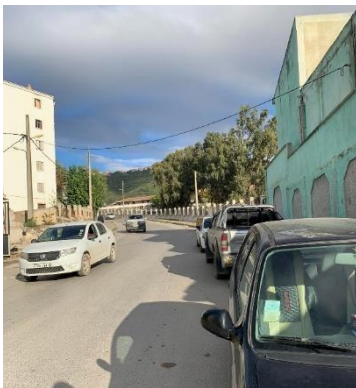
Figure 97 : Vue sur la rue KESRI avant requalification
