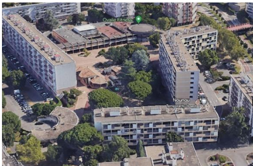
Figure 42 : Vue aérienne sur la place avant la requalification
