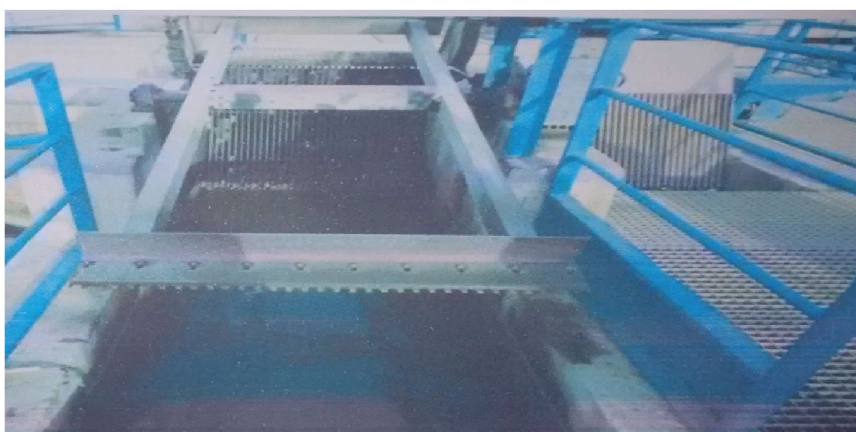
Figure n°10: Dégrilleur
