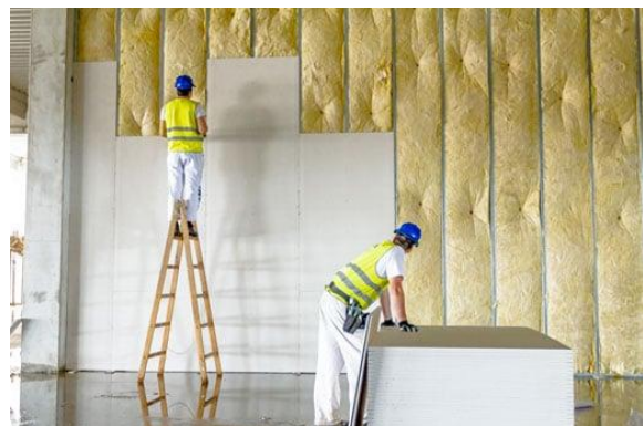
Figure 232: fixation de panneaux de laine de verre
