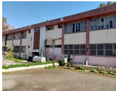
Figure 30: vue sur le pavillon A Source : auteurs
