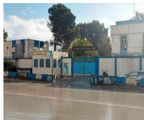
Figure 45: vue sur l'unité de police Source : auteurs
