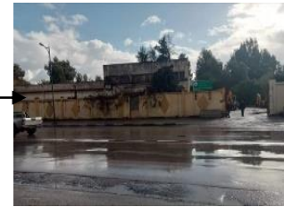
Figure 17:unité de travaux publics
