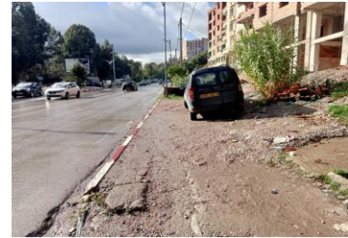
Figure 46: vue sur le trottoir côté nord avenue CHABANE Source : auteurs
