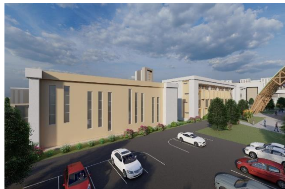
Figure 212:restaurant universitaire après réhabilitation Source : auteurs
