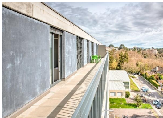
Figure 188: vue du balcon du bâtiment D Source : https://www.cite-uni-geneve.ch/
