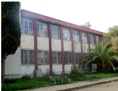
Figure 27:vue sur la façade du bloc B Source : auteurs
