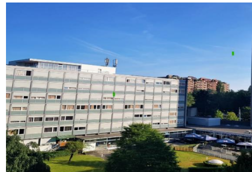
Figure 168:vue sur le bâtiment B Source: https://www.cite-uni-geneve.ch/
