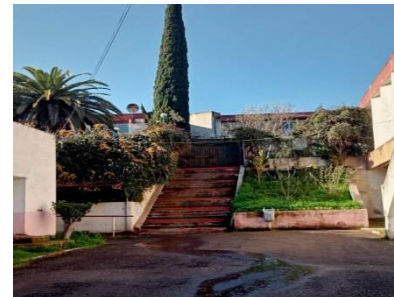
Figure 28:vue sur le portail séparant la résidence et le département Source : auteurs
