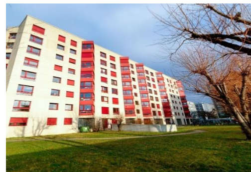
Figure 170: vue sur le bâtiment B Source: https://www.cite-uni-geneve.ch/
