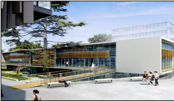
Figure 110: construction de bâtiments dédiés à la vie de campus
