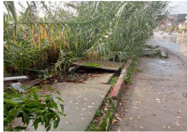
Figure 50: vue sur le trottoir côté sud avenue Chabane Source : auteurs
