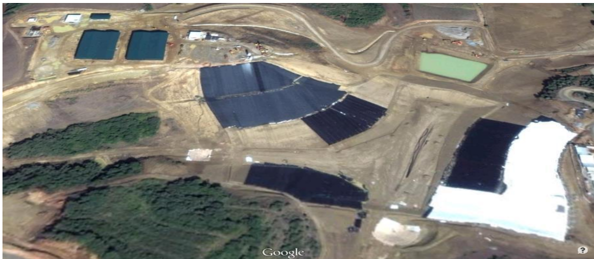
Figure1 : Vue d’ensembles de C.E.T Corso
