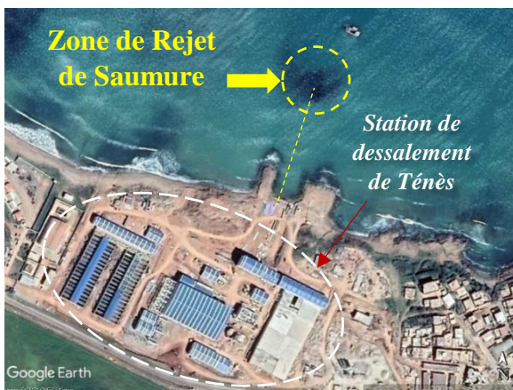
Ténès en construction (31/03/2014)
