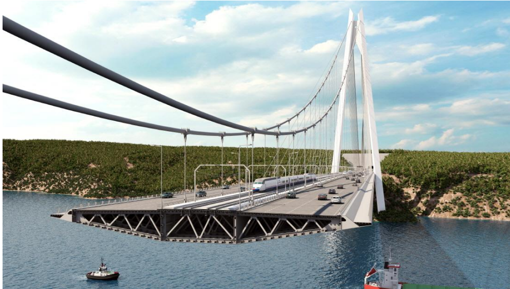
Figure 3-1 : Vue du pont de Bosphore en phase de réalisation
