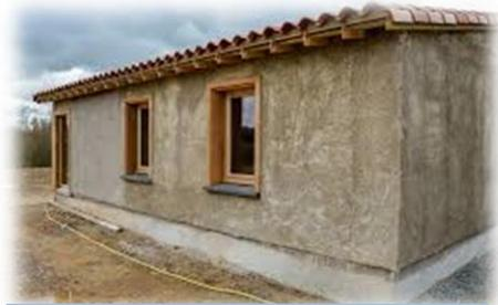
Figure 6 : Béton de chanvre
