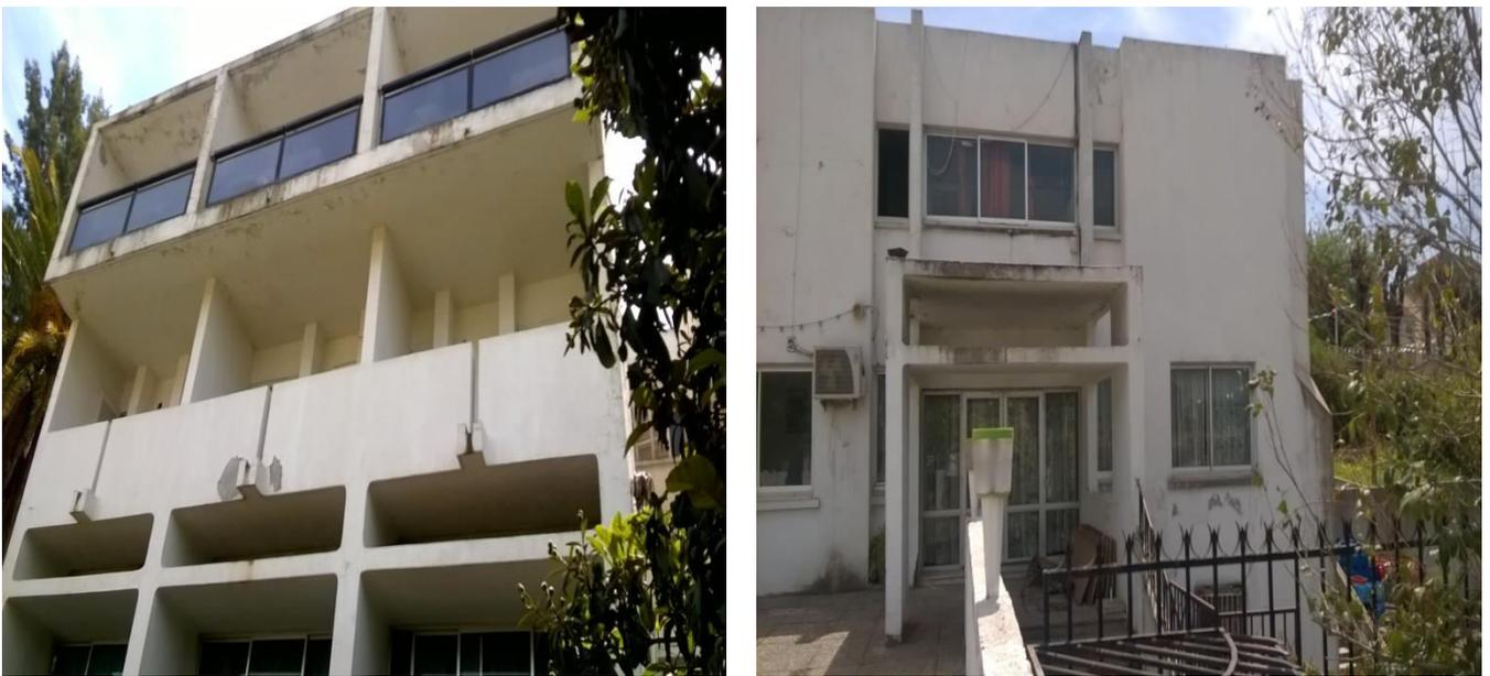
Figure 39: Revêtements en dégradation
