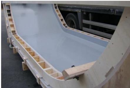
Figure 101: préparation du moule à béton.
