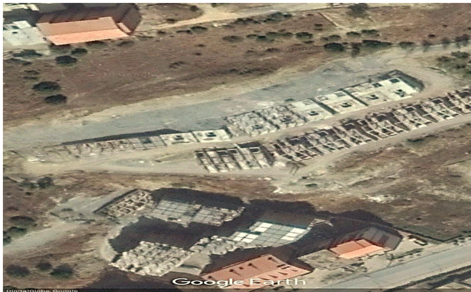
Figure IV-4: Site de prélèvement de la marne 4 les Chabane.
