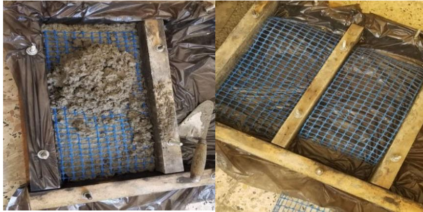
Figure V.8 Coffrage et grilles utilisées
