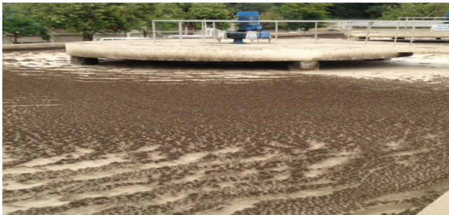
Figure 17 : Bassin stabilisateur (ONA)
