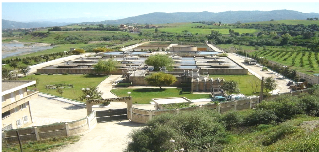
Figure 07 : Vue générale de la STEP
