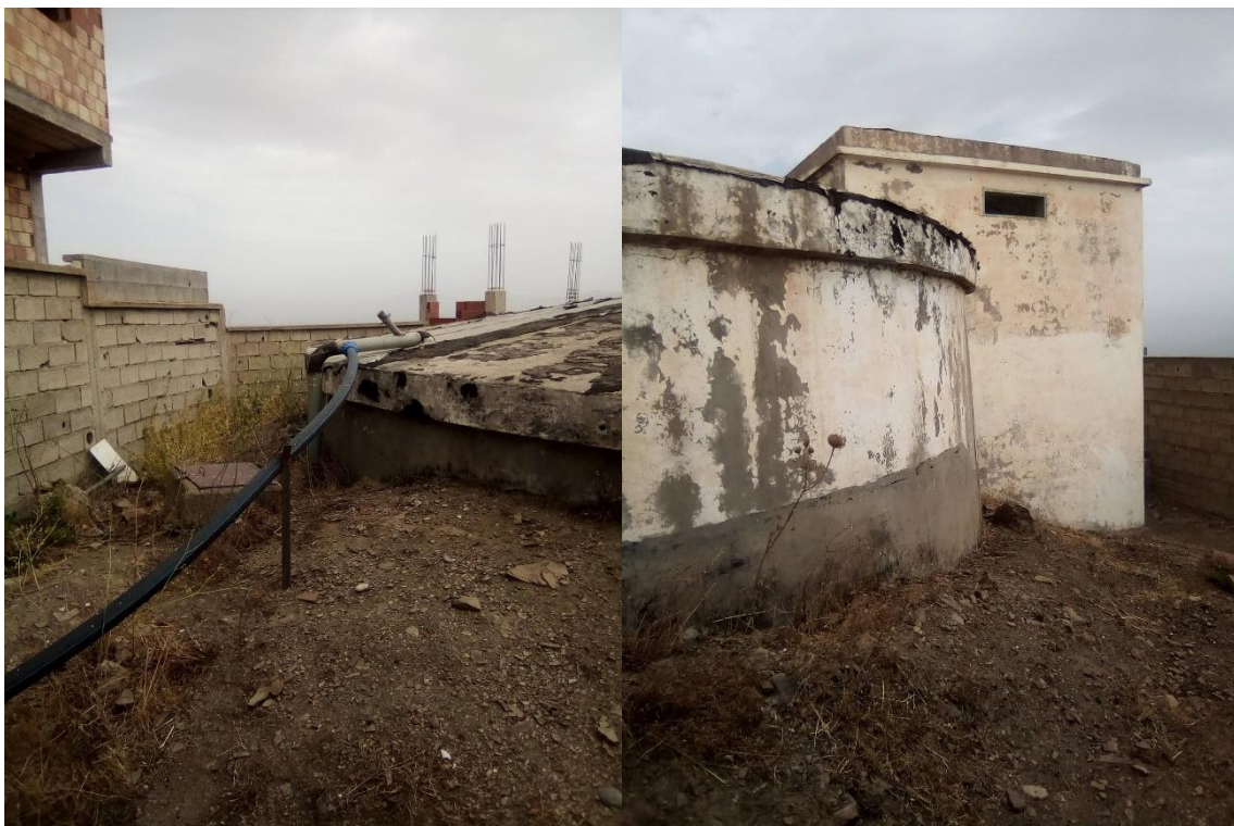
Figure I.9 : état extérieur du réservoir 300m 3 du village MLIHA.
