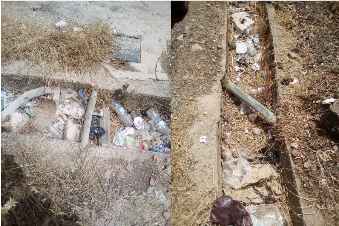
Figure I.7 : conduites de distribution déterrée traversant un caniveau.
