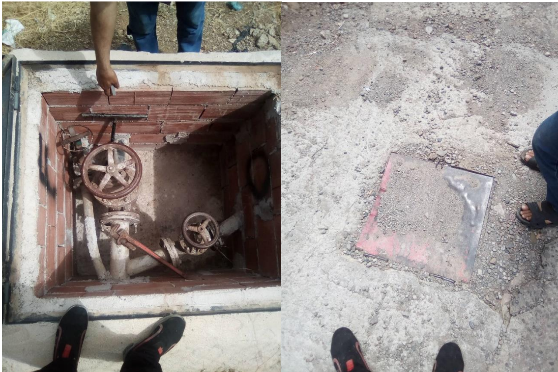
Figure I.8 : Les regards de vanne
