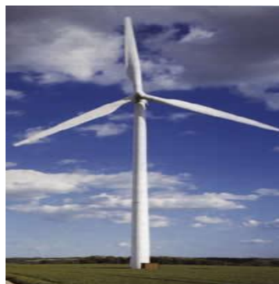
Figure 1-8 : Eolienne à axe horizontal
