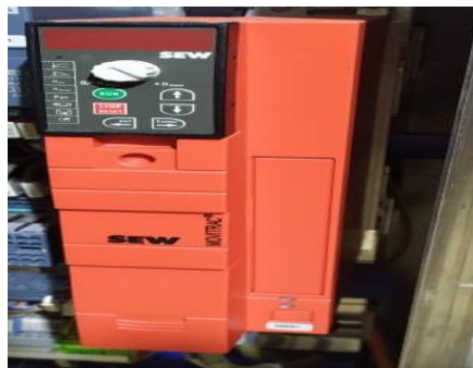
Figure I.27 : Un convertisseur de fréquence.
