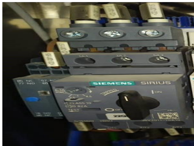
Figure I.29 : Un sectionneur de puissance.
