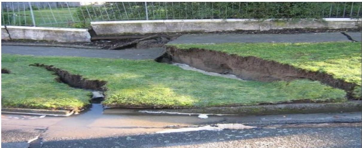
*Figure I. 44. Rupture superficielle et liquéfaction après le tremblement de terre de Christchurch, Nouvelle Zélande (2011).*
