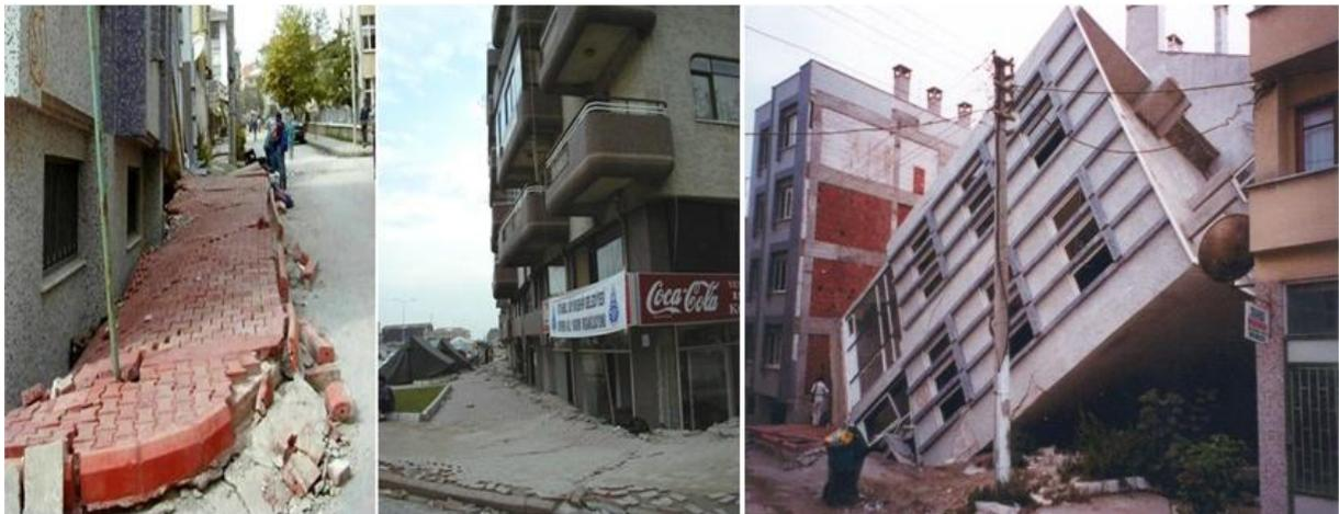
*Figure I. 39. À gauche, Poinçonnement de la fondation sous la liquéfaction. À droite, Renversement d'une structure sous l'effet de la liquéfaction Séisme de Turquie 1999 (d'après Peter M. Byrne et al, 2008).*
