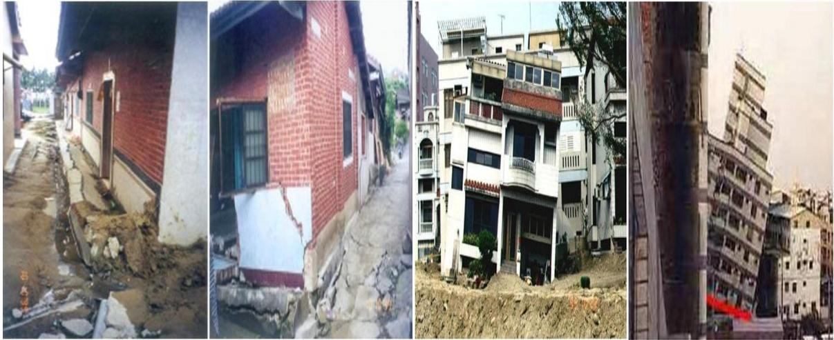
*Figure I. 38. La liquéfaction des sols a causée dans un quartier résidentiel au Comté de Zhanghua, des fissures et des dommages considérables sur les constructions. Séisme de Chi-Chi, 1999.(d'après Dr Hsein, 2002).*
