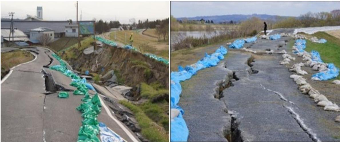
*Figure I. 33. Endommagement des routes : Baisse du niveau de la route due à l'épandage latéral sous l'effet de la liquéfaction du séisme de Tohoku 2011.*
