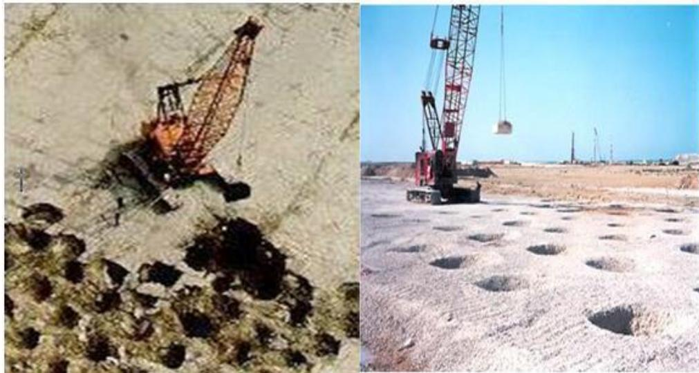
Figure I. 188. *Technique de compactage dynamique.*
