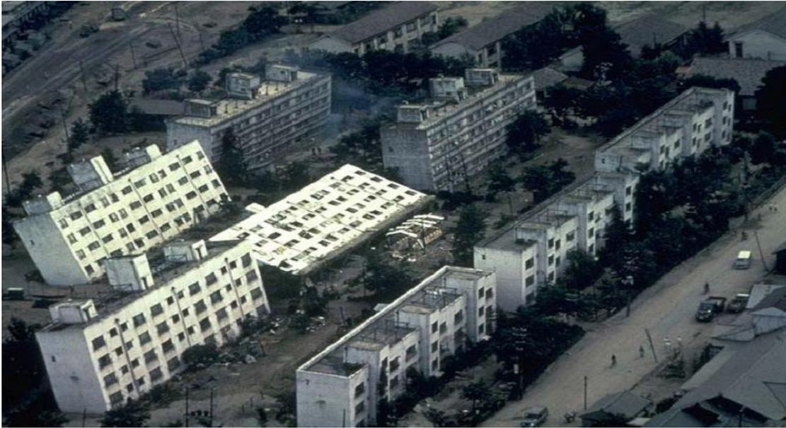
**Figure I. 36.** Inclinaison des bâtiments d'appartements de Kawagishi-cho à Niigata au Japon dues à la chute de la capacité portante du sol par liquéfaction. Séisme de Niigata, 1964. (D'après Peter M. Byrne et al, 2008).
