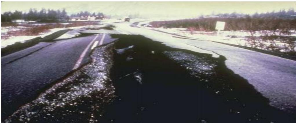
**Figure I.31.** Rupture du sol de fondation, remblais routiers par le séisme d'Alaska 1964.
