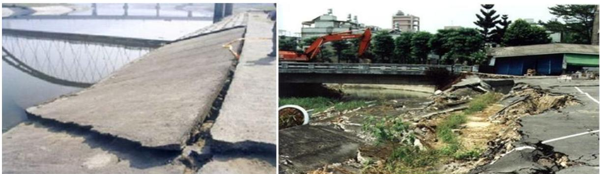
**Figure I. 22.** *Dommages dus à l'épandage latéral du sol en place séisme de Chi-Chi, Taïwan 1999 (d'après Dr Hsein, 2002).*
