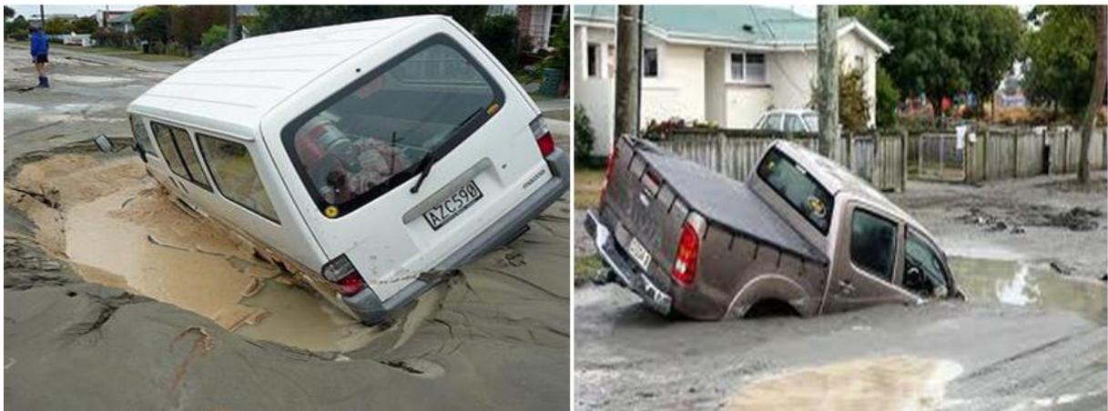
**Figure I. 30.** Une camionnette et un véhicule enlisé dans des trous causés par la liquéfaction des sols après le séisme de Christchurch, Nouvelle Zélande en 2011.
