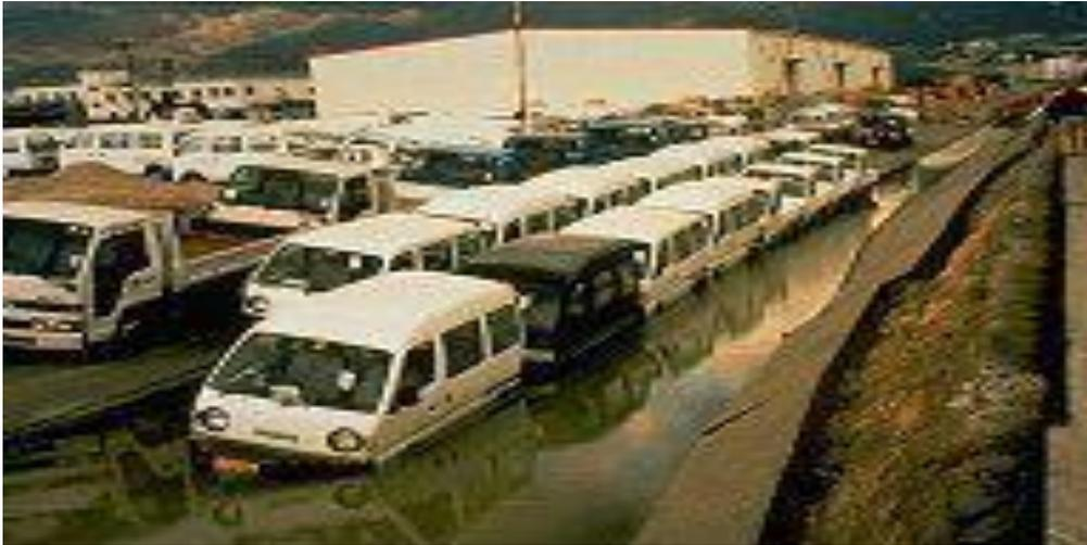
*Figure I. 32. Endommagement des routes (épandage latéral dû à la liquéfaction du sol suite au séisme de Kobé, 1995 au Japon).*
