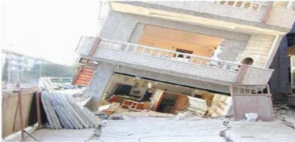
Figure I. 40. Le réez de chaussée de cette structure s'est enfoncé à cause de la liquéfaction induite par le séisme de Boumerdes en 2003.
