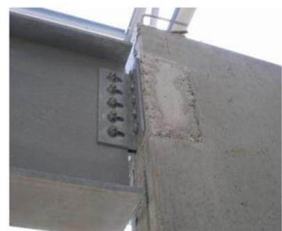
Figure 208 : Détail assemblage poteau poutre
