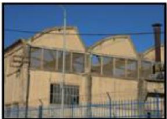
Figure 117 : La SNTF avant intervention.
