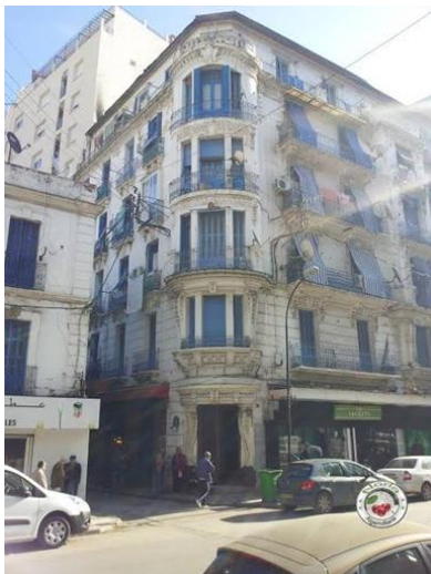
Figure 66 : immeuble construit à l'époque coloniale.
