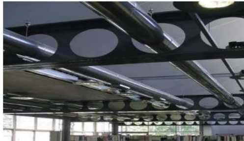
Figure 205 : Poutres alvéolaires
