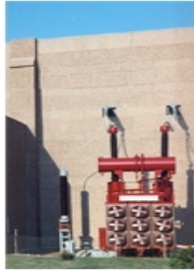
Figure II.8 : réactance de mis à la terre.
