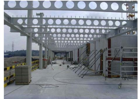
Figure 114: poutre alvéole
