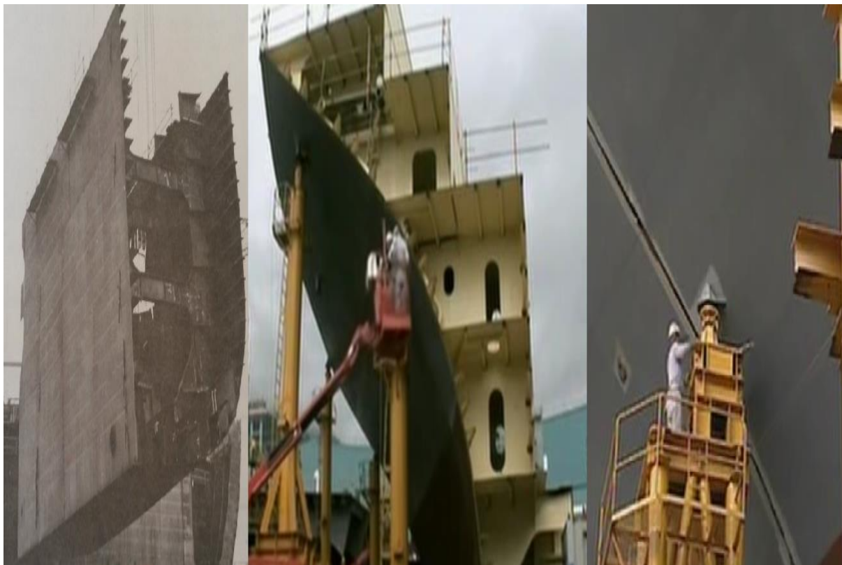
Figure I-20 : construction de la coque du navire. [1]
