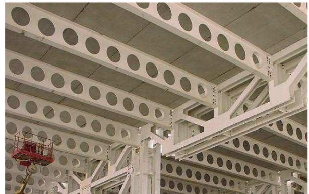
Figure 168: Poutre alvéolaire.
