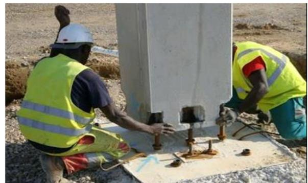
Figure 169 : mise en place du poteau en béton armé préfabriqué.
