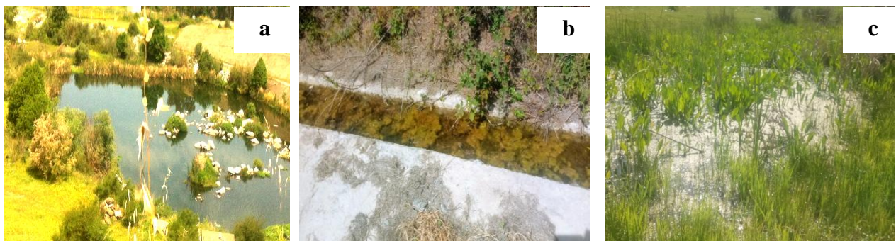
Figure 19. Gîtes permanents du barrage de Taksebt (a, b, c)
