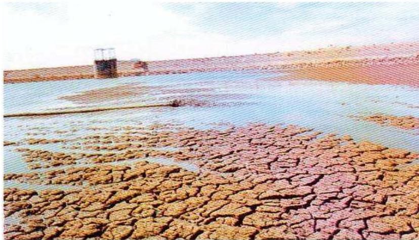
Figure 2.13 : Envasement du barrage Ms Abed (Relizaine).
