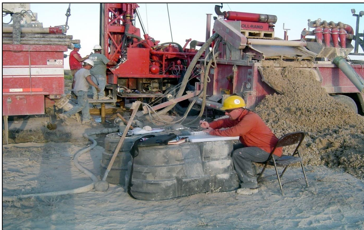
Figure V.6. Opération de réparation de la chemise de la pompe à boue sur le site H.M .[7]
