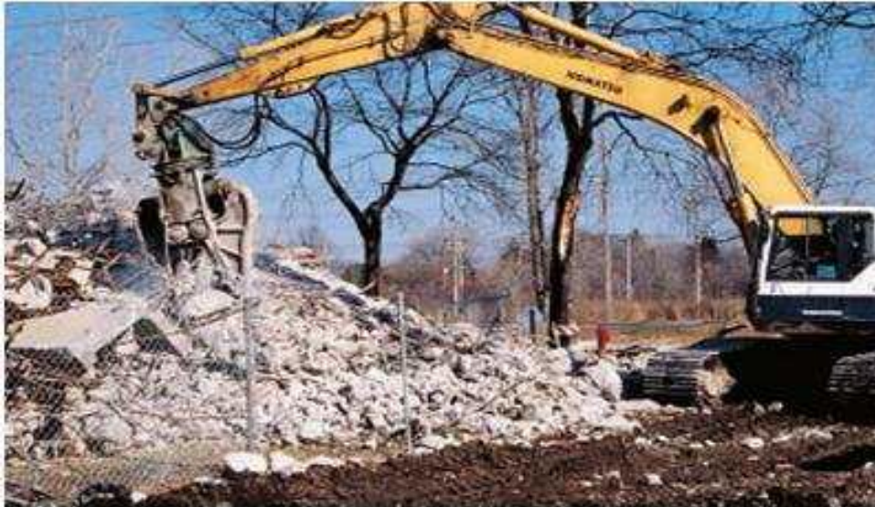
Figure I-3 : Béton fortement armé concassé avec un broyeur.
