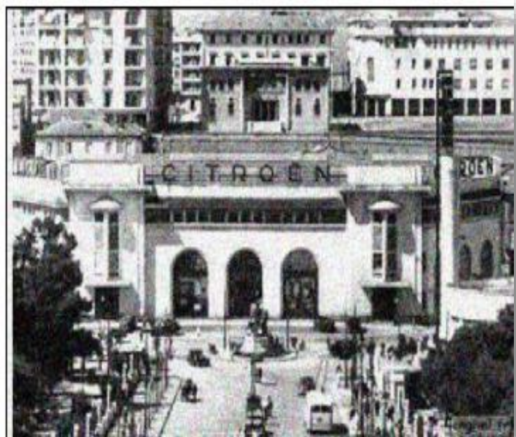
Fig.148. Bâtiment Citroën avant la réhabilitation Réf : Garage Citroën, vue de la façade latérale.1929/PhotoG
