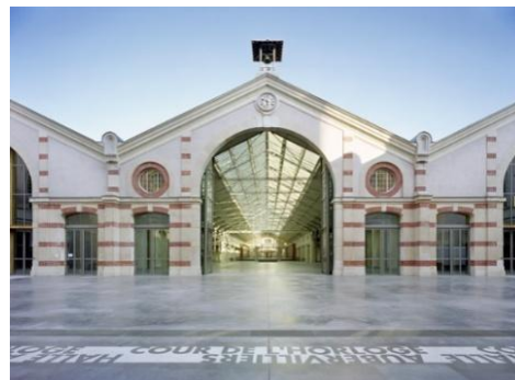
Fig.120. façade extérieure du projet 104 Réf: https://gracevolupteetbetonbanche.wordpress.com/2014/01/15/le-104-paris/
