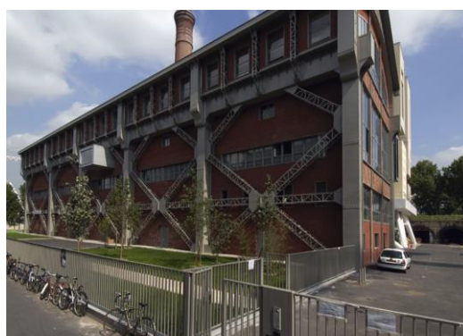
Fig.185. Vue sur la halle après sa réhabilitation Réf : www.paris-valdeseine.archi.fr
