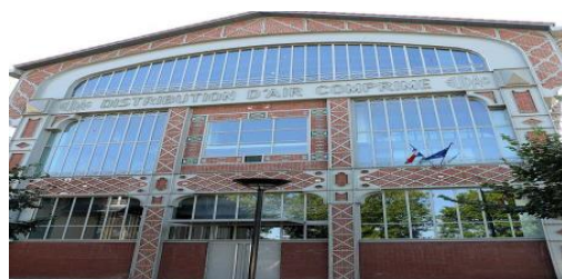
Fig.186. Vue sur la halle après sa réhabilitation Réf : www.paris-valdeseine.archi.fr
