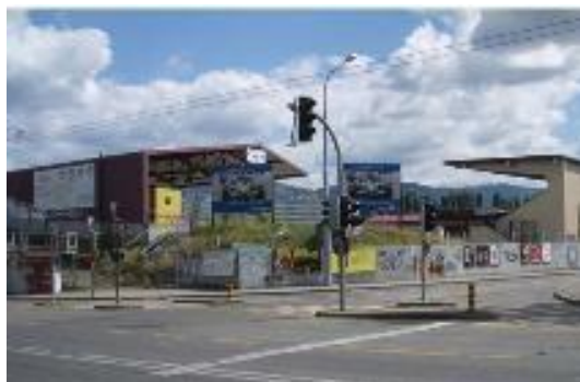
Fig.7. Friche infrastructurale à Genève Réf : http://www.ecoparc.ch/fileadmin
