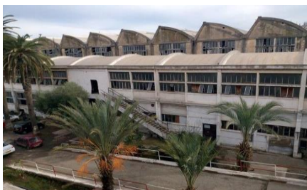
Fig.3. Les ateliers de maintenance d'El Hama
