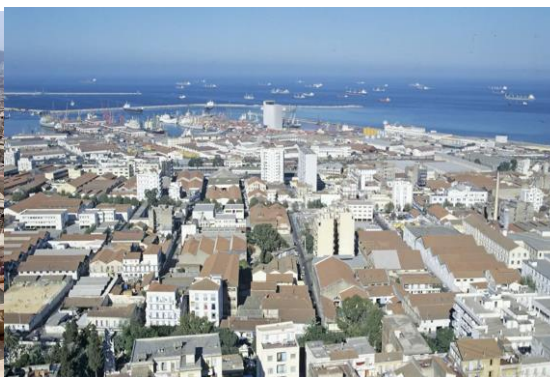
Fig.14. La casbah d'Alger après rénovation
