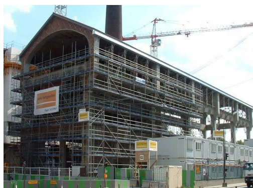
Fig.184. Chantier de réhabilitation de la halle Réf : www.structurae.info
