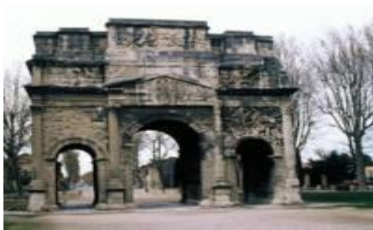
Fig.10. Le Heidentor avant restauration
