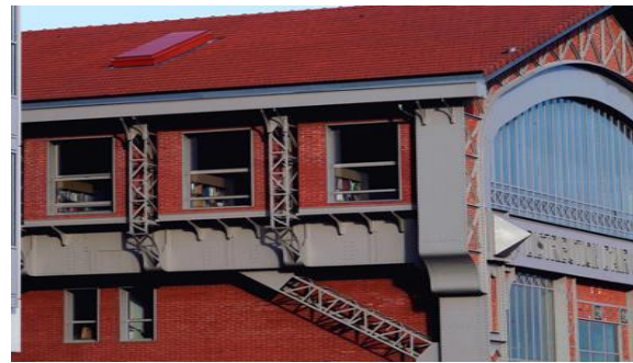
Fig.182. La charpente réparée de la halle Réf : balisejaune.blogspot.com .
