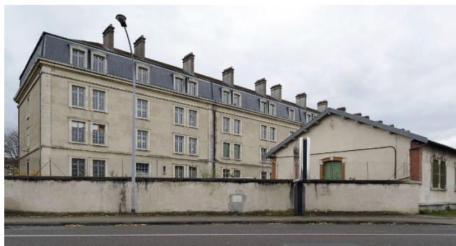
Fig.5. Caserne Vauban, Allemagne, Réf : Milani-Beaudoin Architectes
