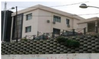
Fig.117. bâtiment R+2 Réf : auteurs
