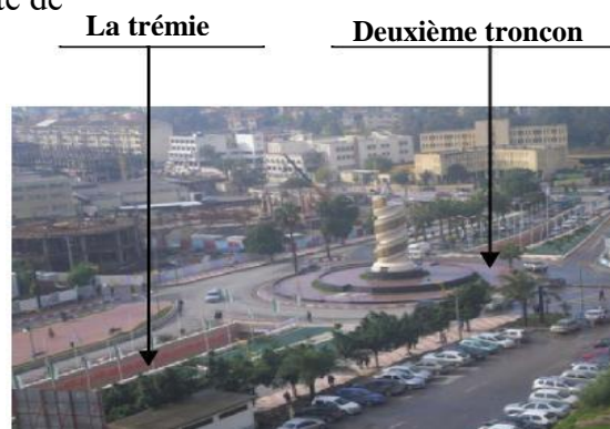
Fig.51. vue sur le deuxième tronçon Réf : photo prise et traitée par auteurs
