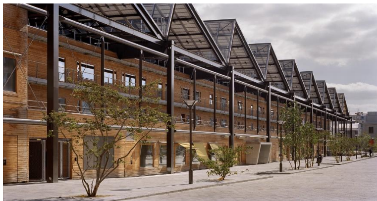
Fig.12. Réhabilitation de la halle Pajol
