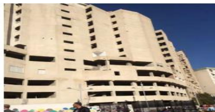
Fig.118. bâtiment R+2 Réf : auteurs
