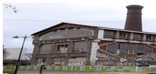
Fig.187. Vue sur la halle après sa réhabilitation Réf : www.paris-valdeseine.archi.fr
