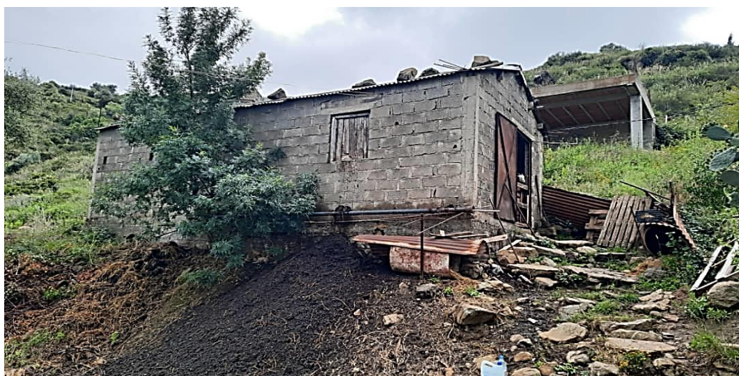
Figure 9: Bâtiment d'élevage type hangar (azefoun.2023).
