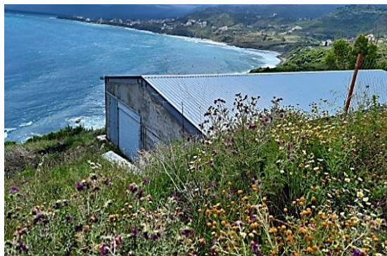
Figure 8: Bâtiment d'élevage type hangar (azefoun.2023).
